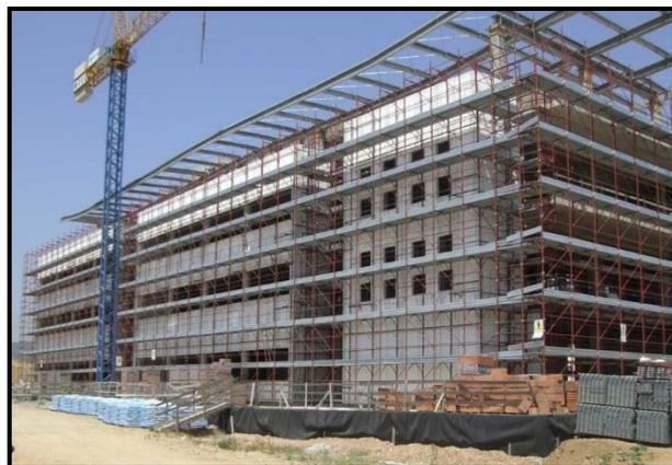
*Imagen 82.* Sistema constructivo paneles estructurales.
