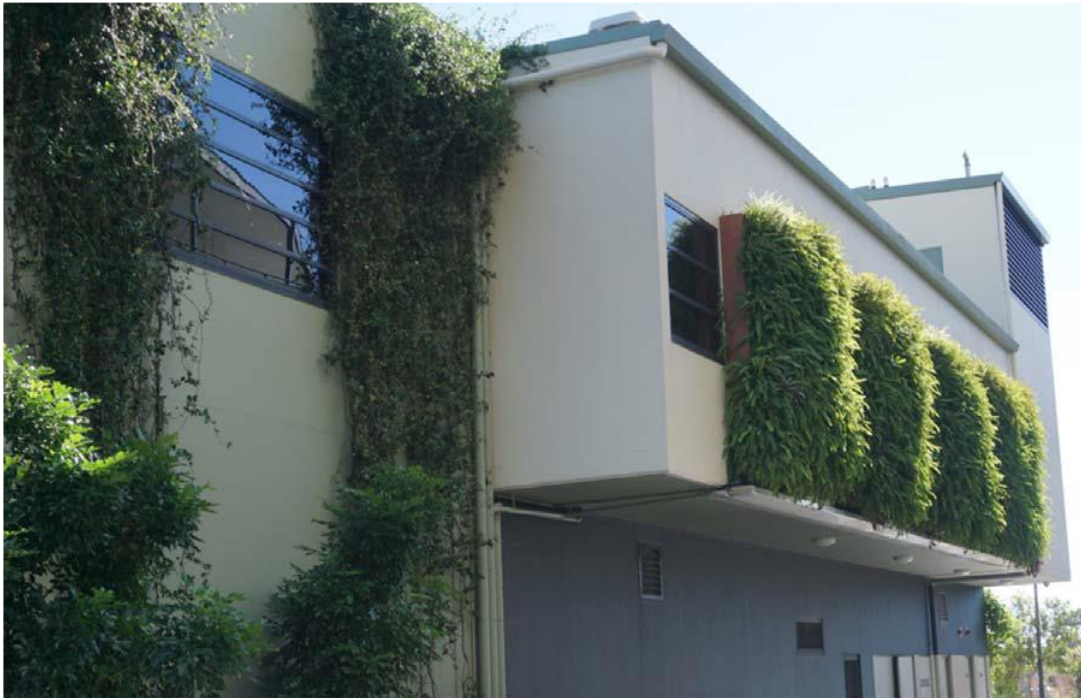
Figura 19. El uso de la vegetación en la fachada para reducir la ganancia de calor y agregar a la estética.
