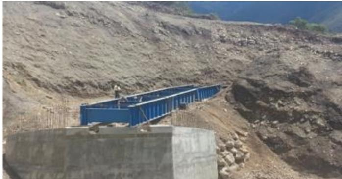
*Figura 10.* Estructura del puente tipo viga “Chilcamayo”.
