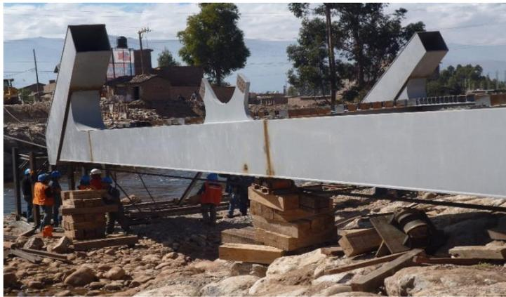
*Figura 02.* Deflexión excesiva de la plataforma de la superestructura.
