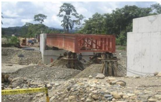
*Figura 16.* Tipo de lanzamientos de puente utilizando el método de apoyos intermedios.
