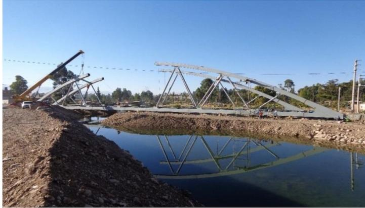
*Figura 04.* Procedimiento de montaje de superestructura anti técnica e inadecuada.
