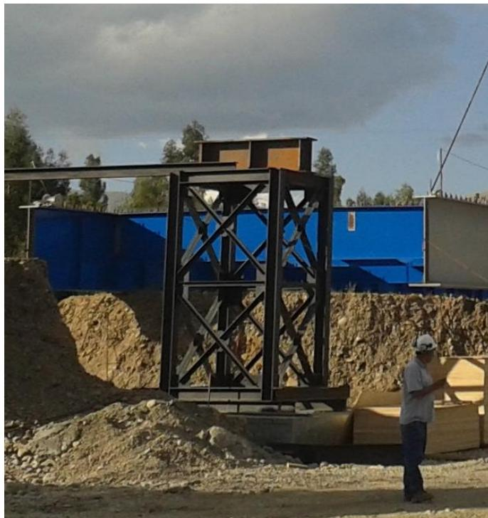
*Figura 19.* Torre provisional de apoyo metálico para el proceso de lanzamiento de la plataforma.
