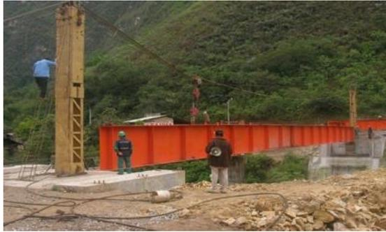
*Figura 15.* Tipo de lanzamiento de puente utilizando el método de cables de forma aérea.
