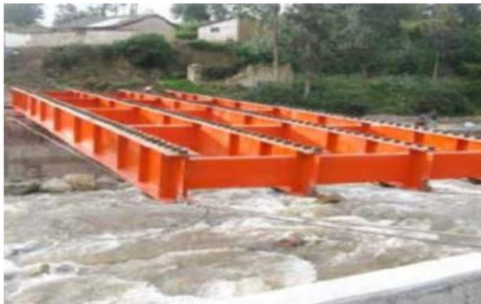
*Figura 14.* Tipo de lanzamiento de puente utilizando el método de cables como huella.
