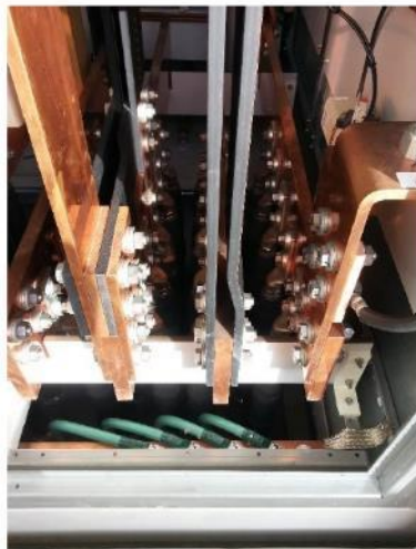
Conexiones entre barras y terminales del motor de molino.
