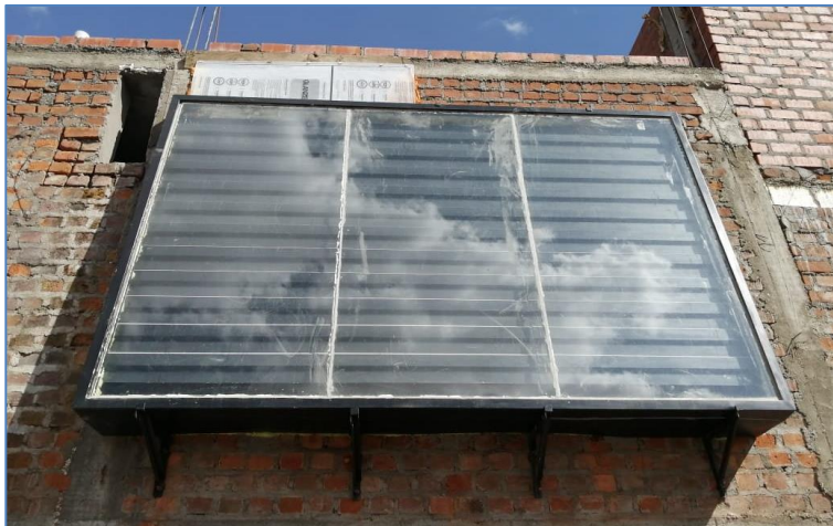
Figura 48: Vista del colector solar térmico de aire. Fuente: Elaborado por los investigadores.
