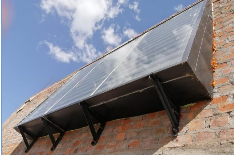
Figura 49: Vista de perfil del colector solar térmico de aire. Fuente: Elaborado por los investigadores.
