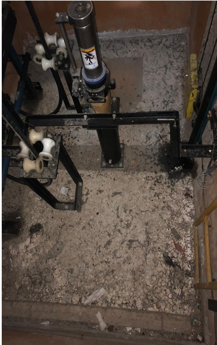
Figura 6 Foso de ascensor
