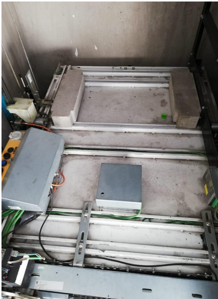
Figura 5 Cabina de ascensor vista interna desde techo
