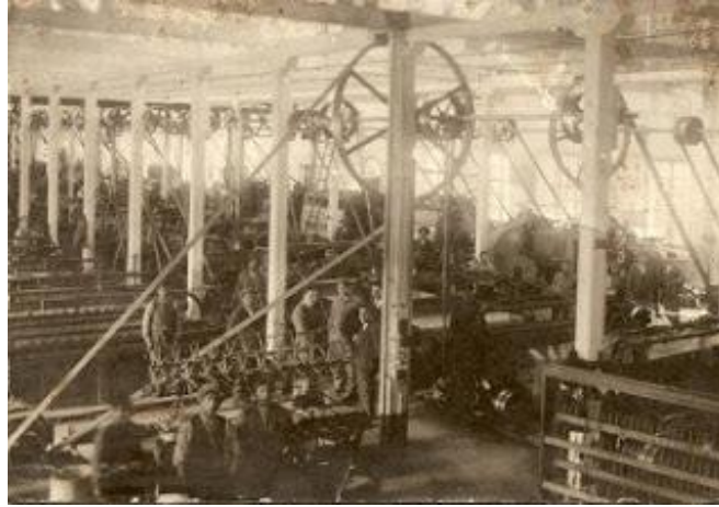
Figura 5. Sala de máquinas 1919. Adaptada de "Patrimonio industrial en el Perú, Breve historia de hilados y tejidos de Lucre". Cusco, 2009, Hidalgo, N. ( https://patrimonioindustrialperu.blogspot.com/2009/07/breve-historia-de-la-fabrica-de-hilados.html )
