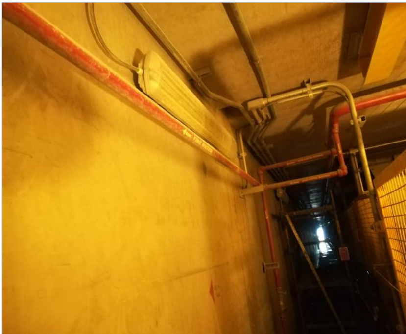
Ilustración 49: Iluminación con fluorescentes Fuente: HUDBAY- Constanca
