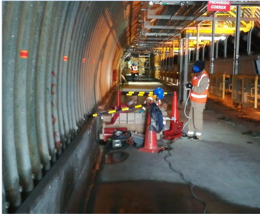
Ilustración 54: Realizando trabajo de calibración de iluminación
