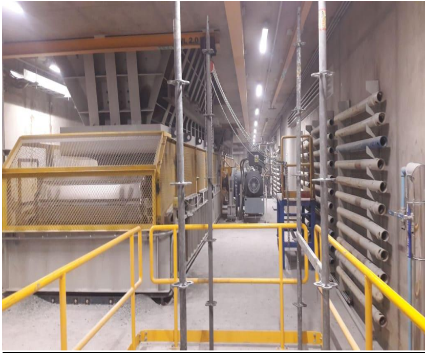
Ilustración 45: Iluminación LED APRON FEERER segundo nivel
