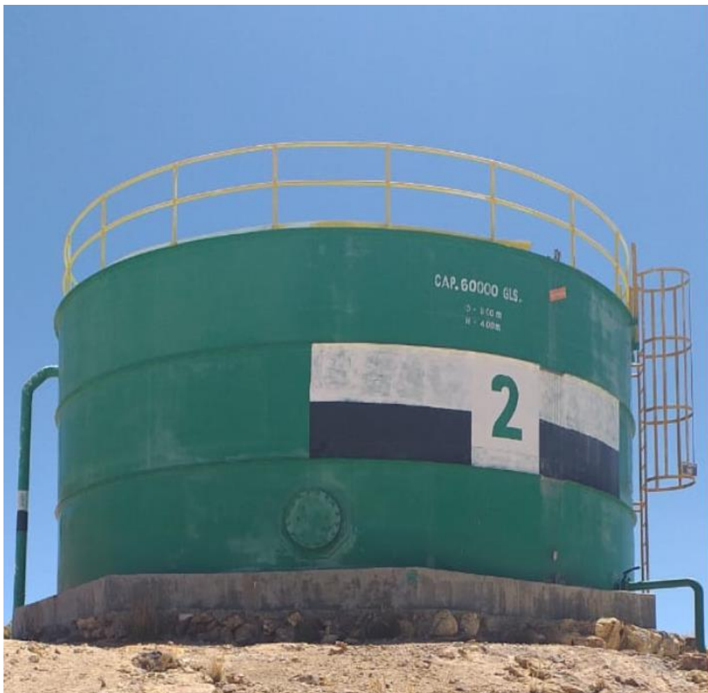
Figura 34. Tanque 2 de almacenamiento de agua Fuente: elaboración propia
