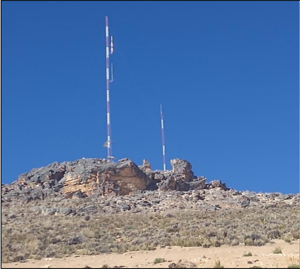
Figura 36. Torre de señal de antena repetidora de comunicaciones Fuente: elaboración propia
