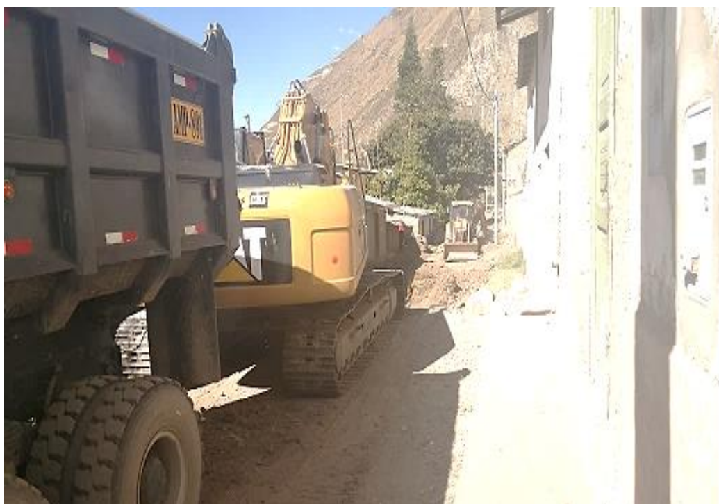
Fuente: Panel fotográfico de la supervisión del proyecto
