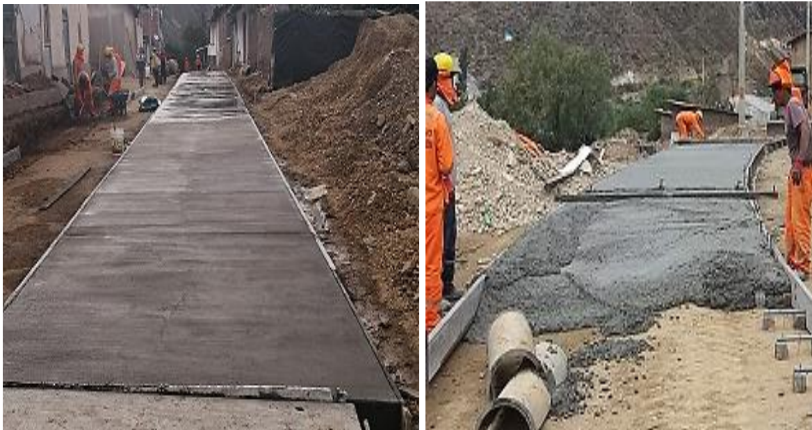
Figura 19: Encofrado de losas
