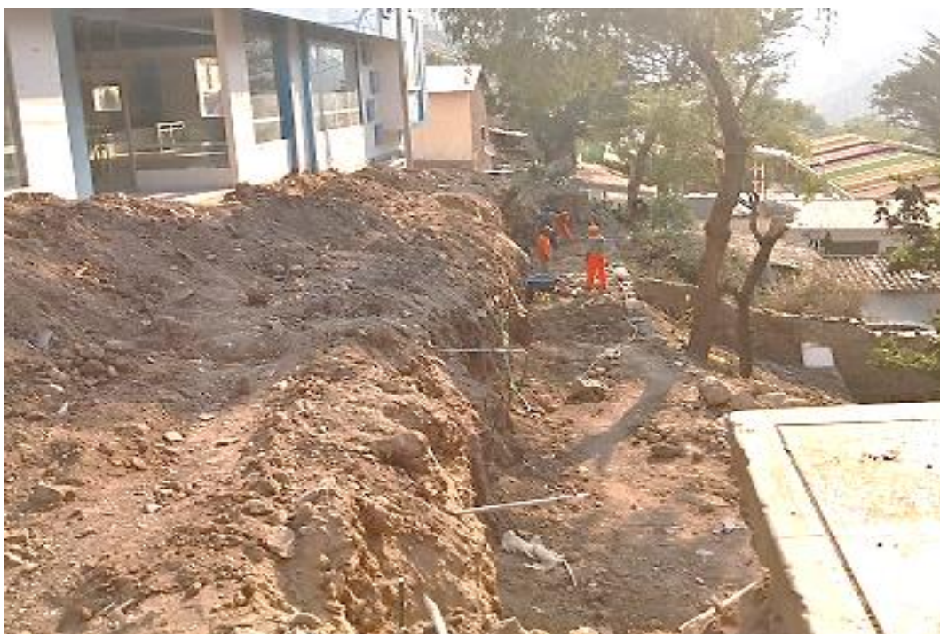
Fuente: Panel fotográfico de la supervisión del proyecto.
