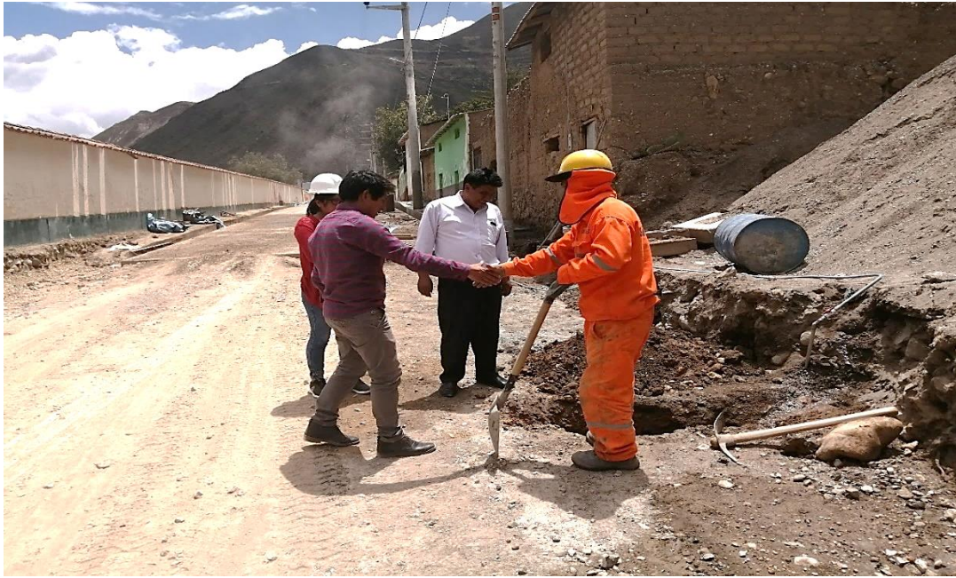
Fuente: Panel fotográfico de la supervisión del proyecto.
