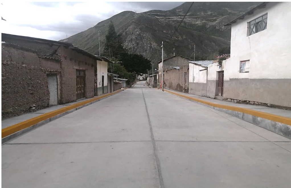
Fuente: Panel fotográfico de la supervisión del proyecto.
