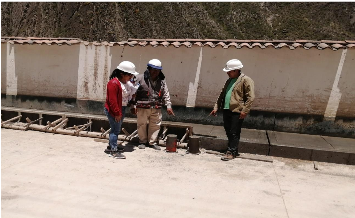
Figura 20: Gestión de calidad – Prueba de resistencia a la compresión del concreto
