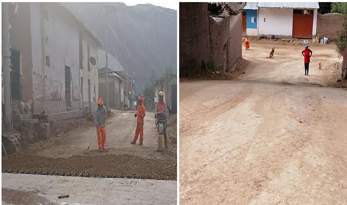
Fuente: Panel fotográfico de la supervisión del proyecto.
