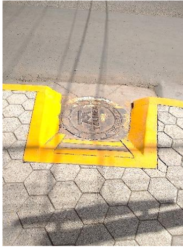
Figura 10: Rampa ubicada en la Av. Giráldez.
