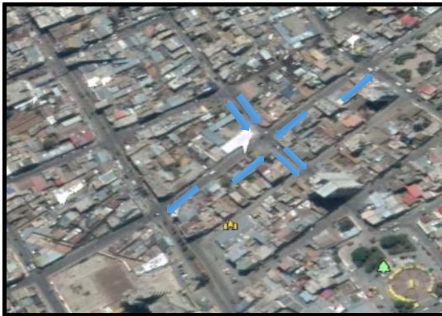
Figura 81: Dirección de vehículos en la intersección I2
