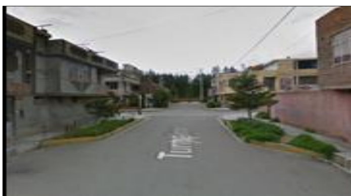
Figura 3: Estrechamiento de carril en la Calle Turmalina - El Tambo – Huancayo.
