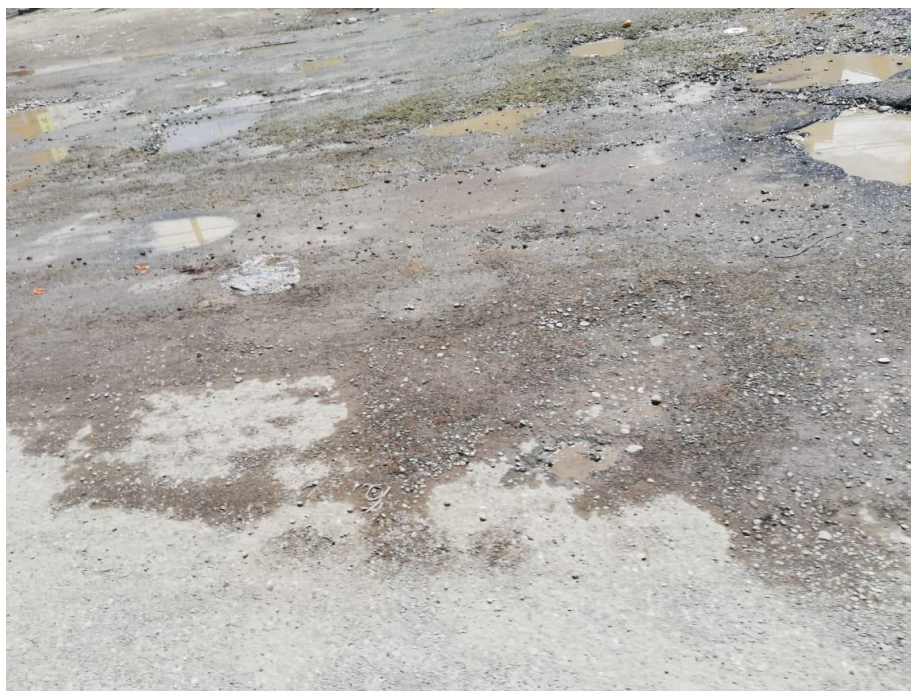
Figura 2. Ejemplo de condición del tramo: Emp. PE-3S ubicado frente a la UNCP
