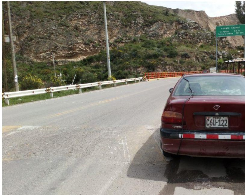
Figura 5. Carretera Central – Ingreso al puente Stuart Jauja
