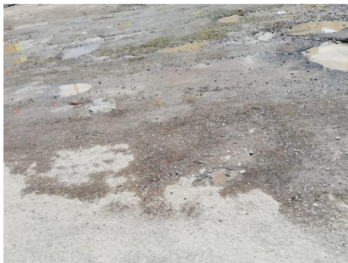
Figura 21. Inspección visual de la carretera Central
