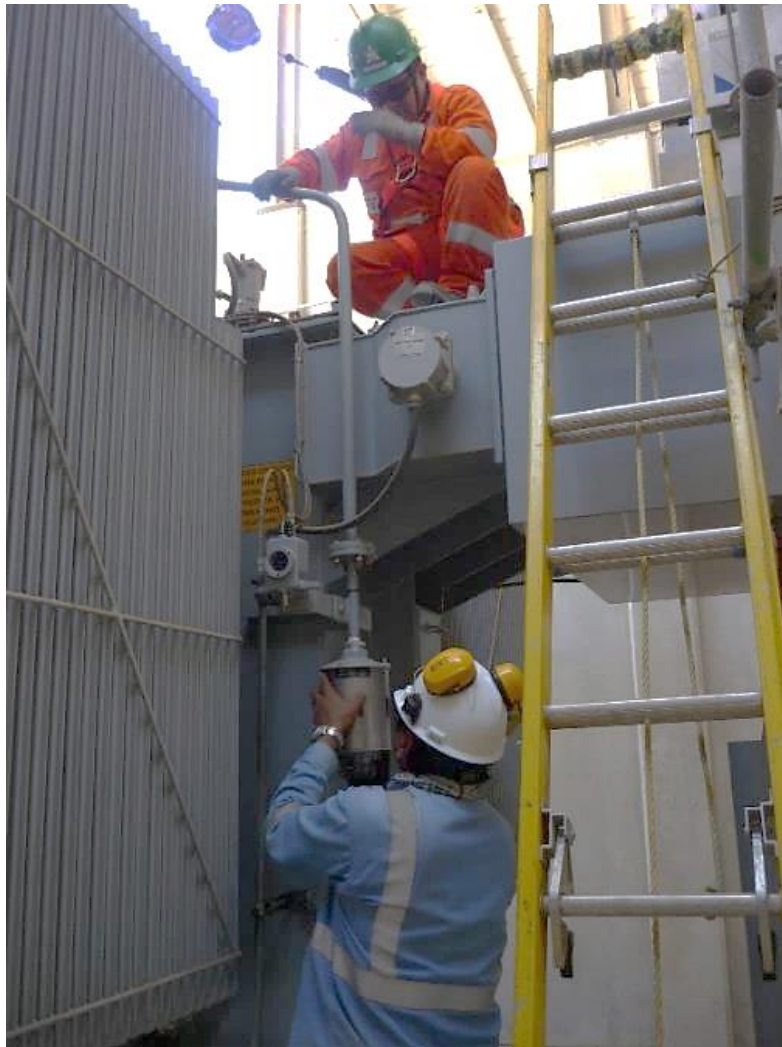
Figura 24: Instalación del respiradero al finalizar el llenado de aceite al transformador de potencia
