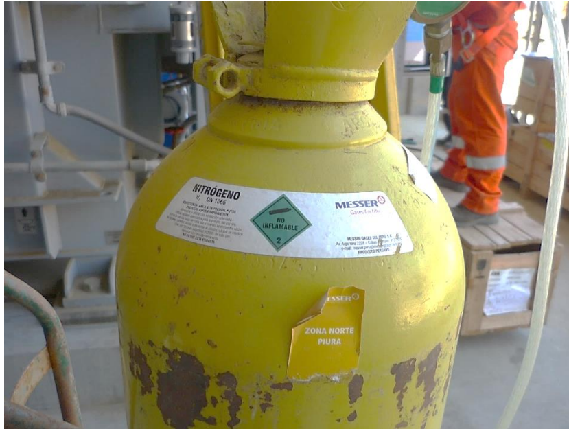
Figura 14: Retiro y llenado de nitrógeno del radiador del transformador de Potencia
