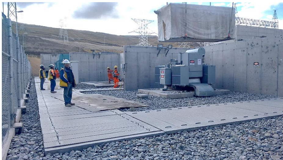
Figura 8: Técnica de la planificación en montaje de equipos eléctricos.
