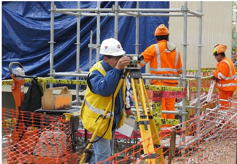
Figura 10: Verificación topográfica niveles de montaje transformador de potencia.
