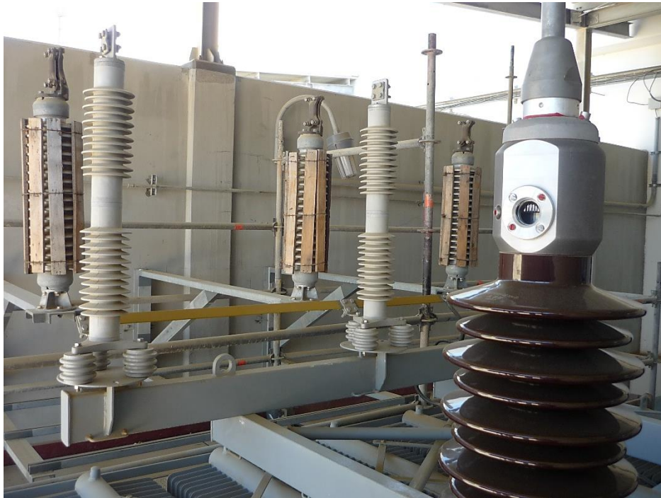
Figura 20: Montaje de pararrayos antes de la entrada a los bushings del transformador de potencia
