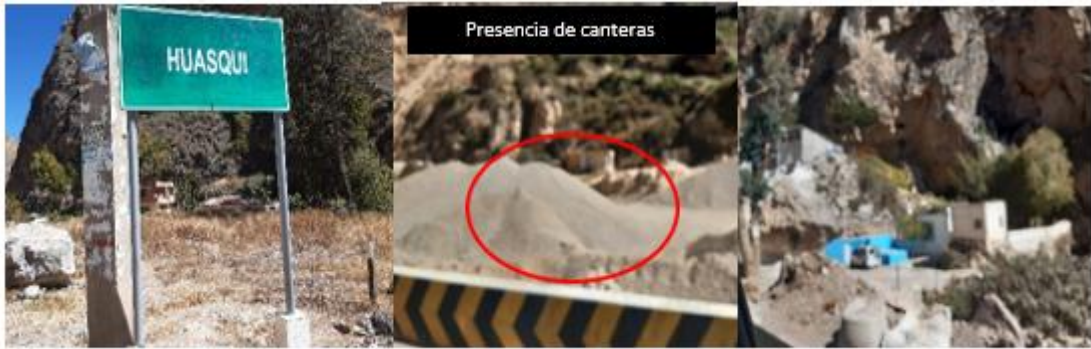
Fotografías del 27 al 29: Presencia de canteras a las orillas del río.
