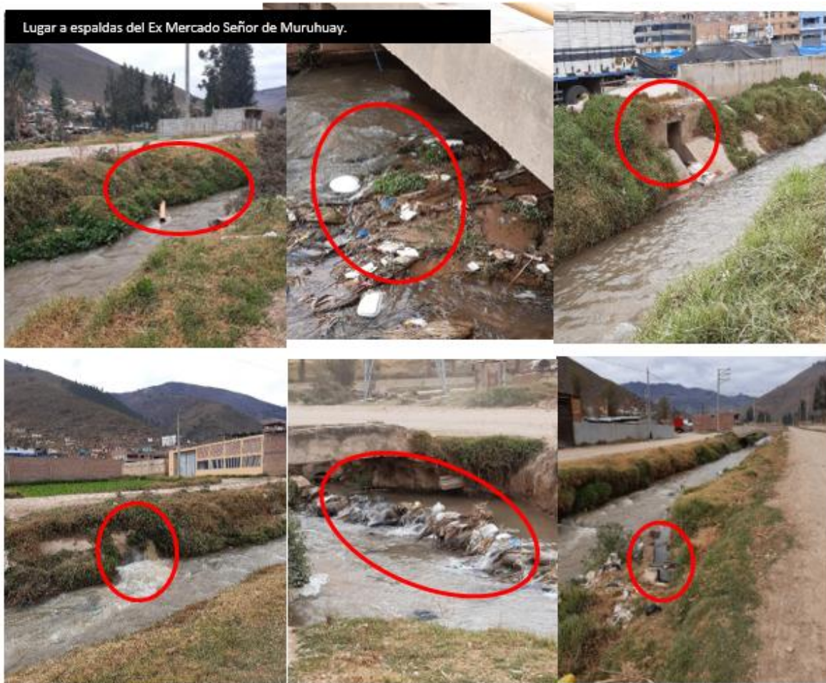
Fotografías del 41 al 46: Vertimientos directos de desagües y residuos sólidos al río.
