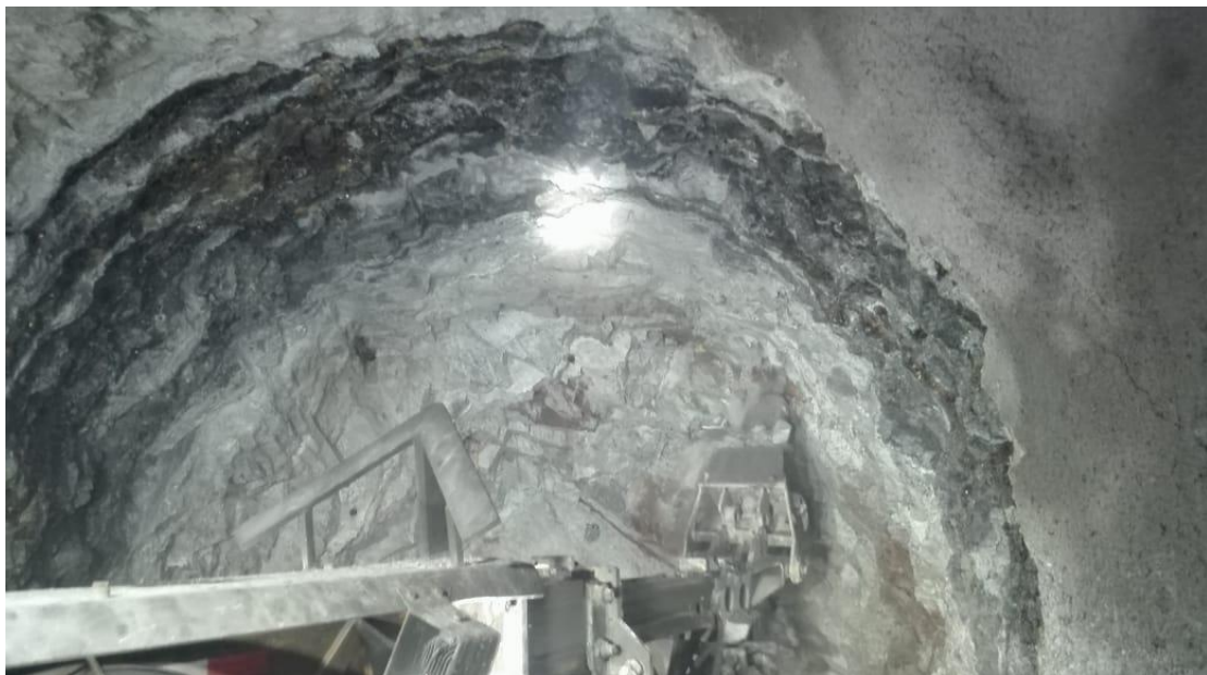
Voladura controlada en labor de desarrollo
