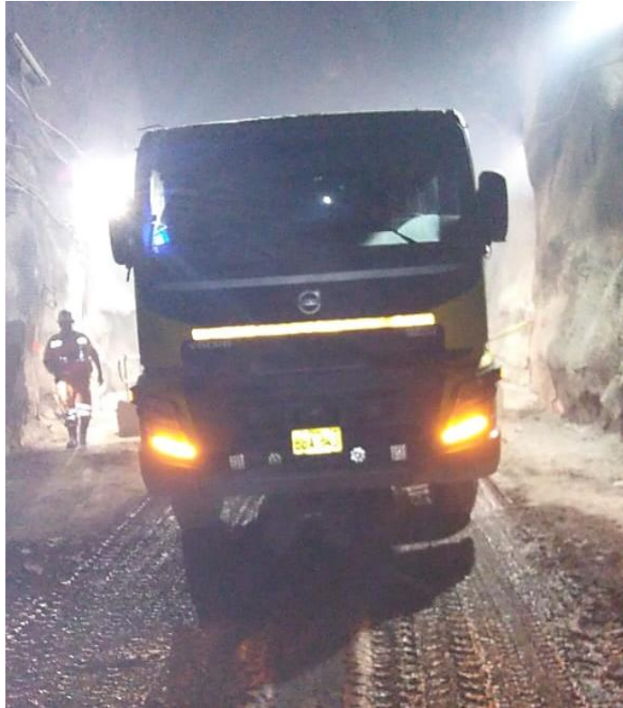
Volquete transportando desmorte
