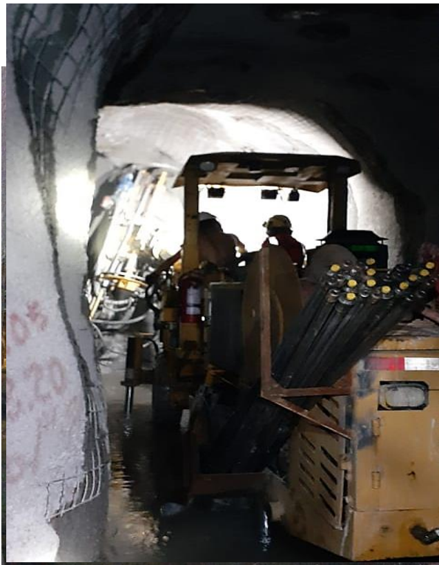
Instalación de elementos de sostenimiento
