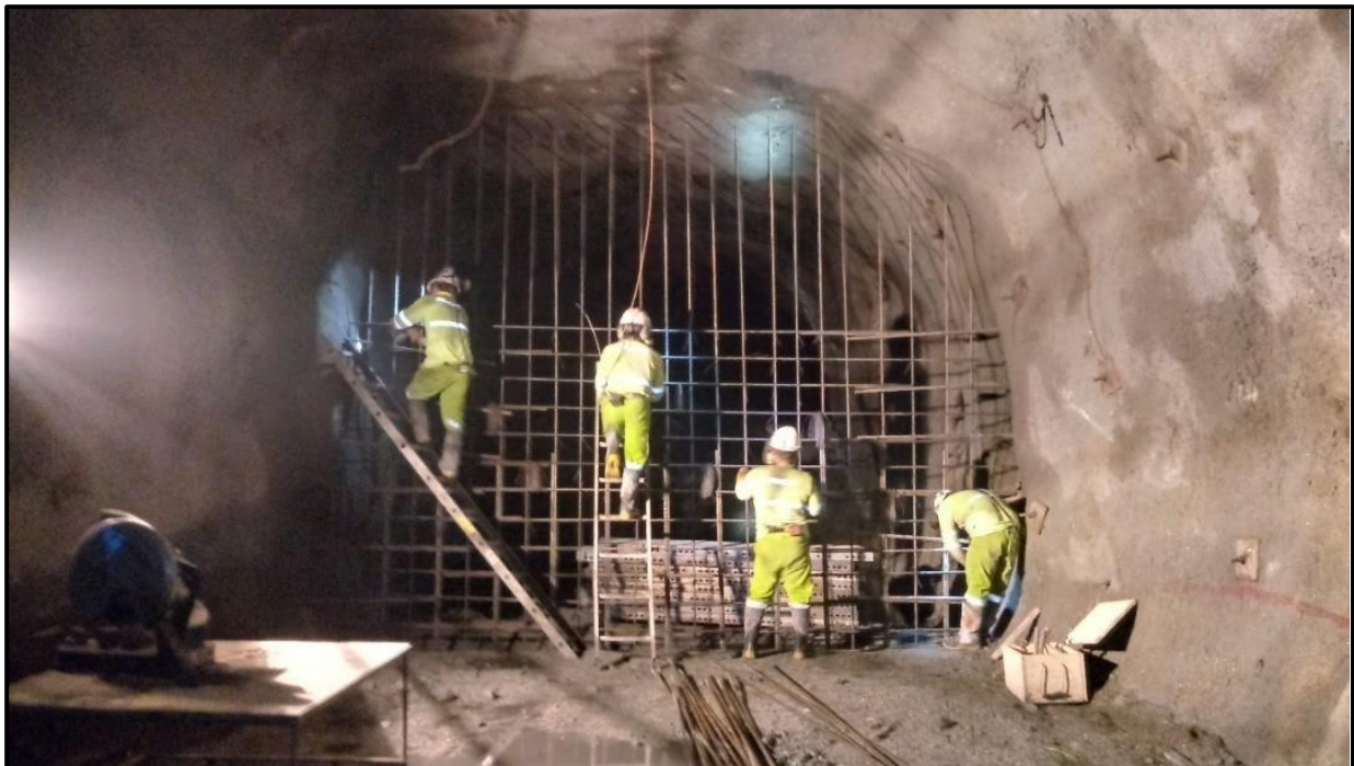
Figura 14. Estructurado 1er nivel de un muro tapón de concreto.
