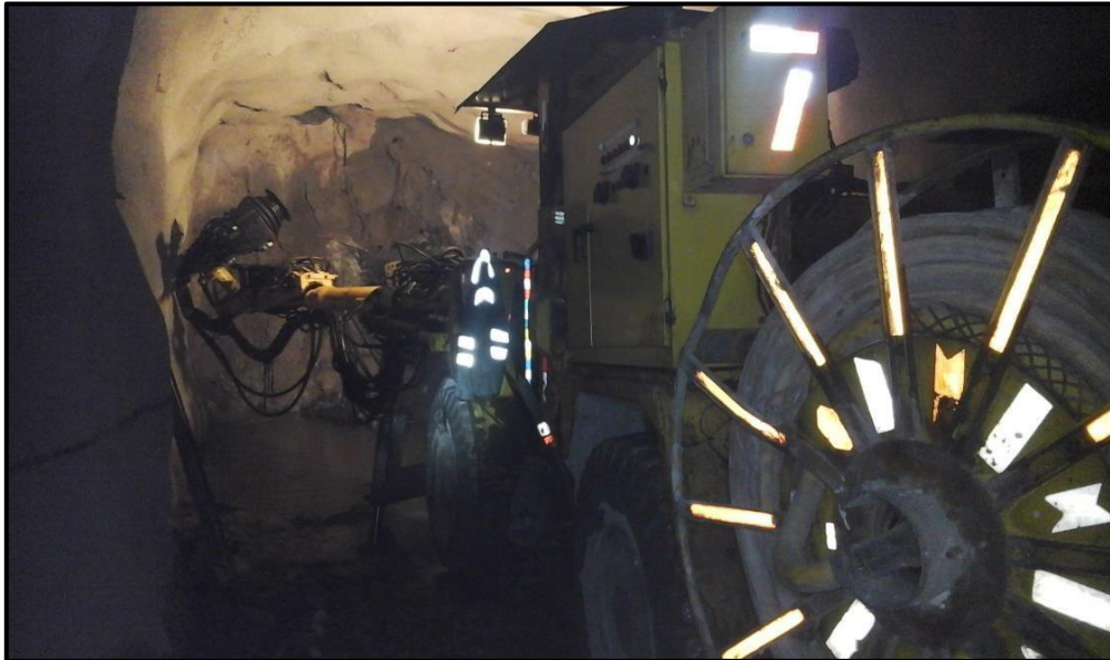
Figura 3. Equipo perforador frontonero en perforación.
