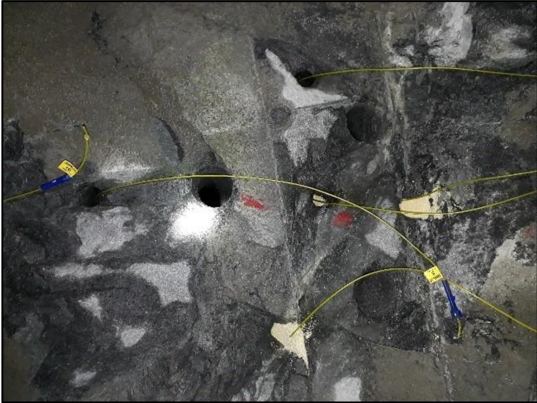
Figura 4. Frente cargado y amarrado.
