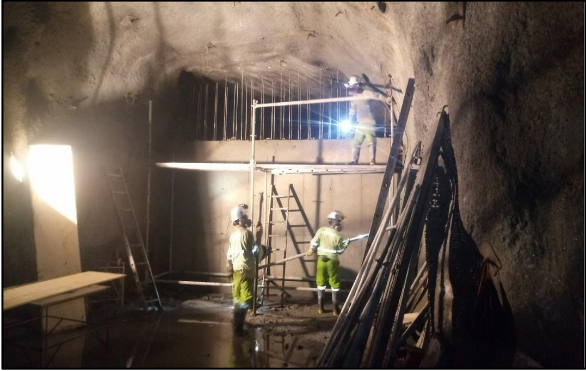
Figura 15. Construcción del 2do nivel de un muro tapón de concreto
