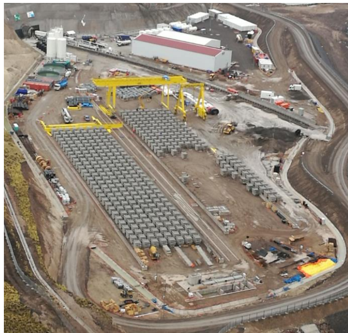
Figura N° 20: Acopio de dovelas en proyecto. Fuente: Propia.
