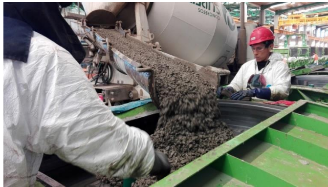
Figura N° 13: Colocación de hormigón. Fuente: Propia.
