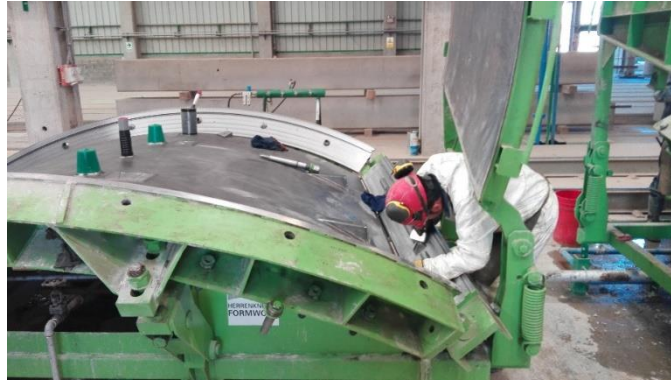
Figura N° 12: Aplicación de desencofrante en molde. Fuente: Propia.
