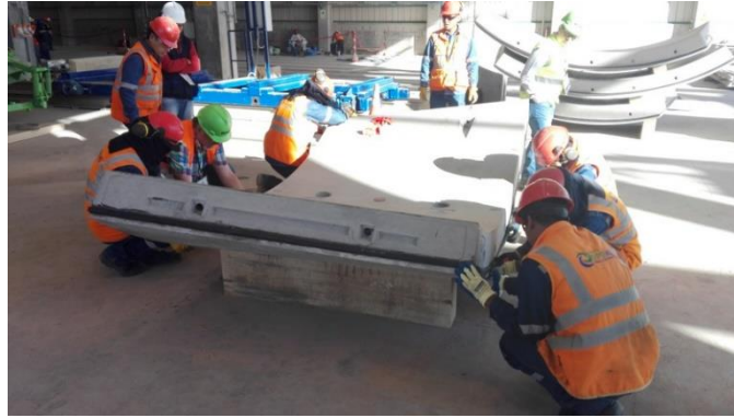
Figura N° 17: Colocación y pegado de junta. Fuente: Propia.
