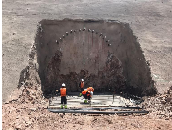
Figura N° 24: Obras preliminares del túnel. Fuente: Propia.
