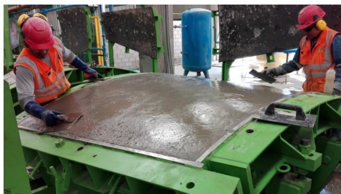
Figura N° 14: Fratasado de superficie. Fuente: Propia.
