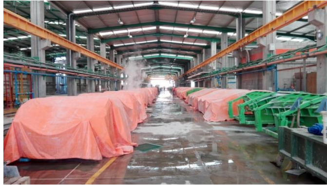
Figura N° 15: Curado del hormigón. Fuente: Propia.
