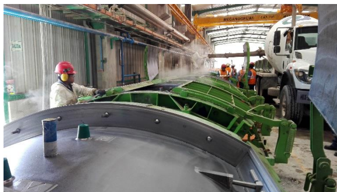
Figura N° 11: Limpieza de molde de dovela. Fuente: Propia.
