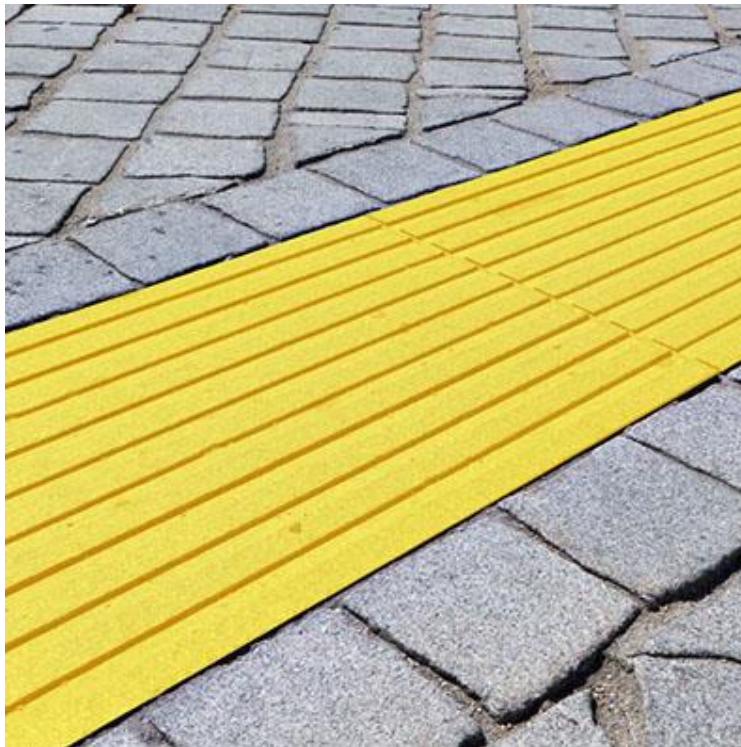
Figura N° 17: Laminas Lineales – Sistema podotáctil
