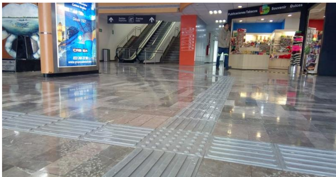
Figura N° 22: Lámina de rodones – Sistema Podotáctil
