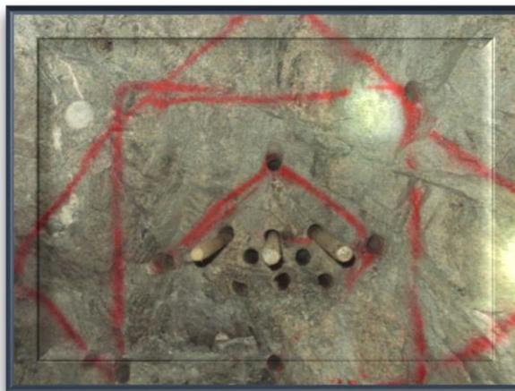
**Figura 22** Ejemplo de perforación de arranque, fuente: Elaboración Propia.
