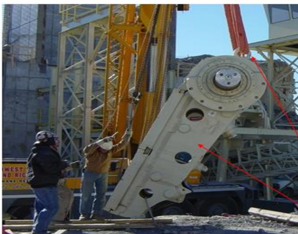
Fig.17 Levantamiento del Pitman.
