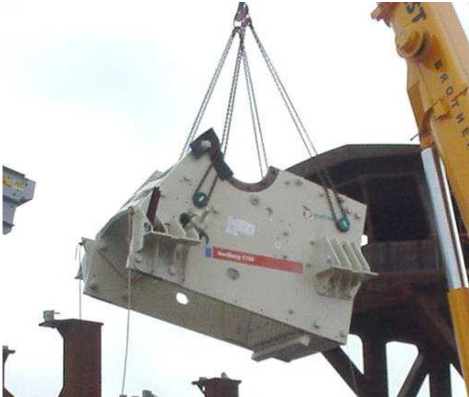
Fig.13 Levantamiento Quijada.
