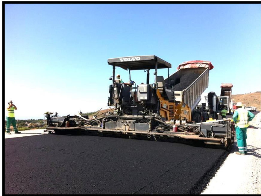
Figura 3: Tendido de mezcla asfáltica
