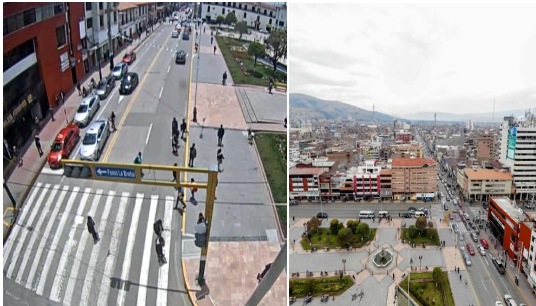
Fotografía 5: Estado de conservación de la calle Real
