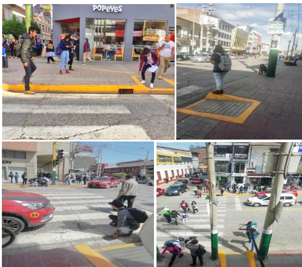
Fotografía 1: Estructura de la calle Real
