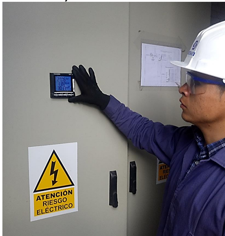
Anexo 16. Analizador de redes Fijo Socomec Diris A20
