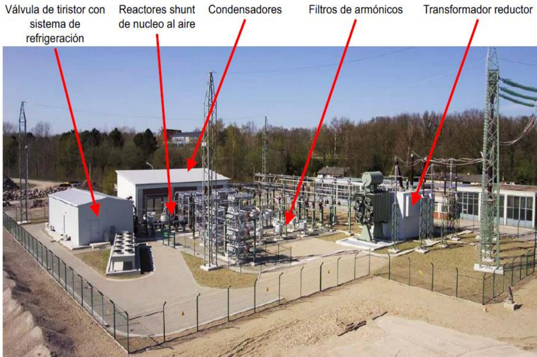
Figura 38: Complejo de un SVC y distribución de equipos
