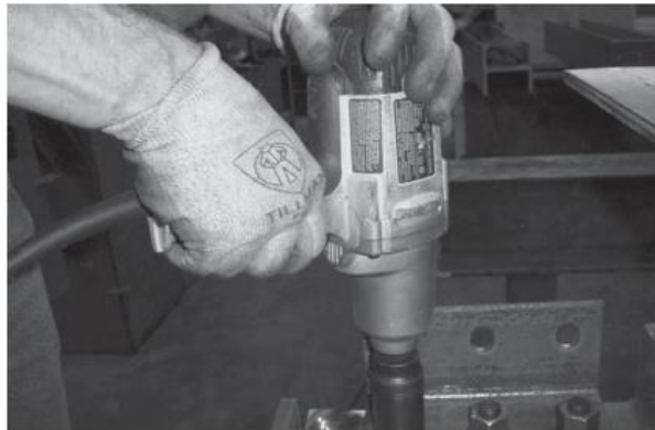
Figura N:5. Ajuste de tornillo con pistola neumática
