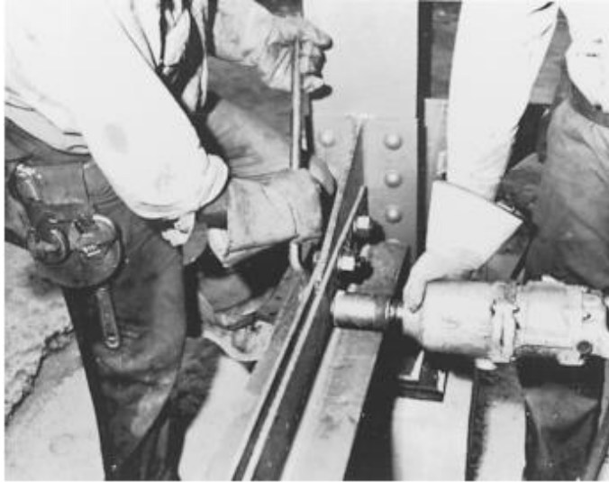
Figura N:6. Ajuste de perno con ayuda de una llave de boca.
