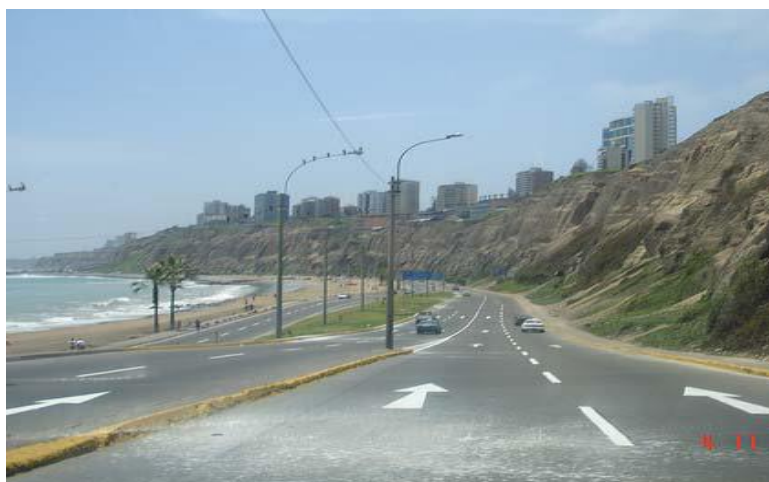
Figura 9. Inicio de la construcción de la vía principal de la C.V. (1970)
