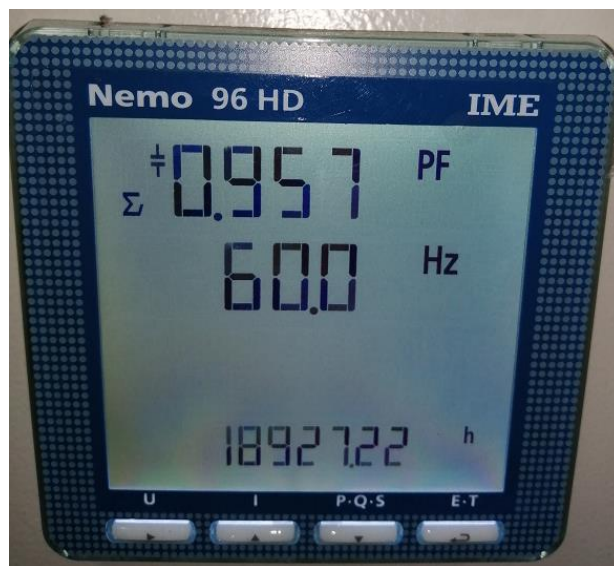
Figura 24: Factor de potencia, frecuencia y números de horas de funcionamiento Fuente: elaboración propia
