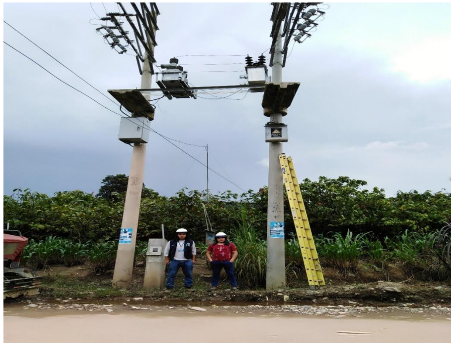
Figura 14. Recorrido de las instalaciones de Edelsa (Recloser).
