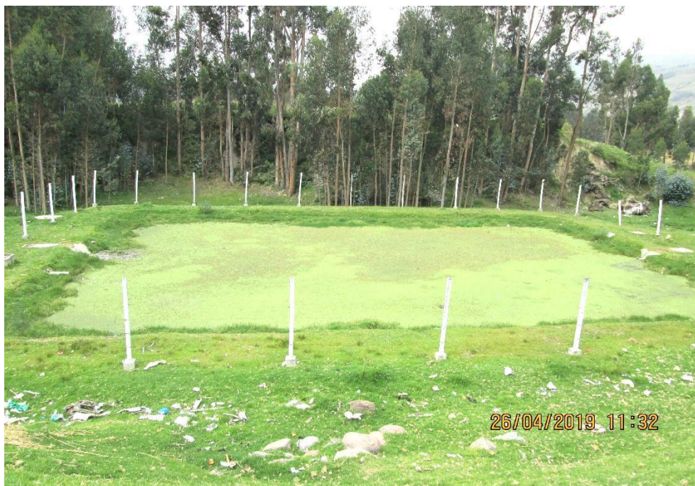
Figura 1 Laguna de oxidación en Sapallanga
