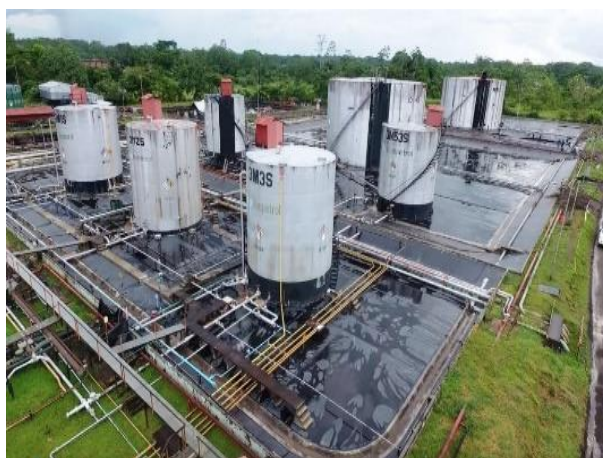
Figura 7. Tanques de Almacenamiento de crudo-Batería 01. Tomado de “Impermeabilización de Áreas Estancas Lote 8”, por D. Manrique, 2019.
