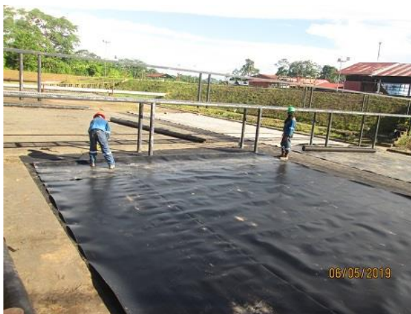
Figura 20. Habilitado e instalación de geomembrana
