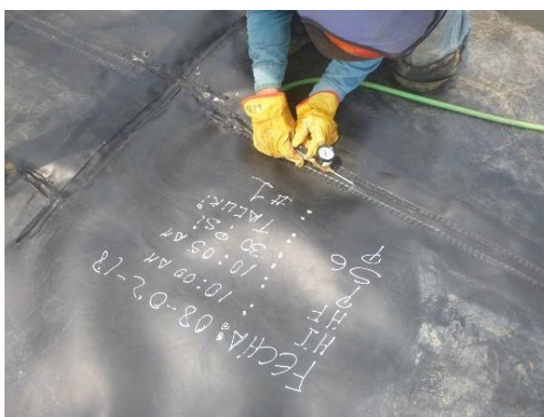
Figura 28. Ensayo de presión de aire
