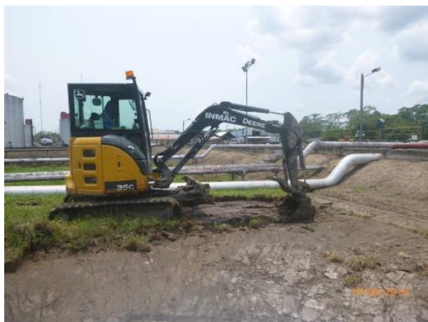
Figura 12. Excavación de terreno con Maquinaria
