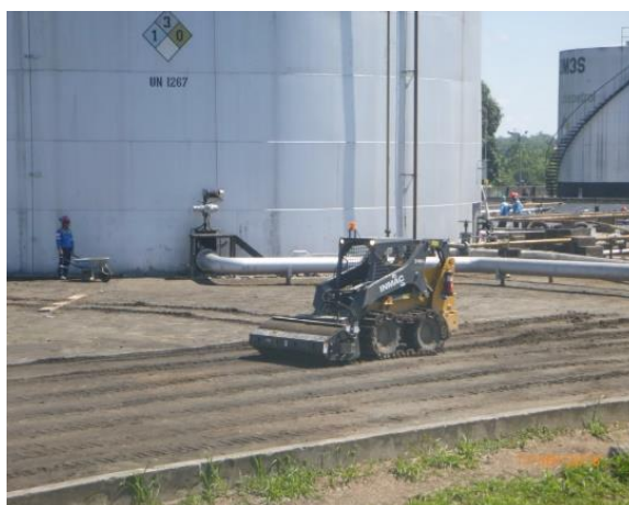
Figura. 15. Compactación de terreno con maquinaria
