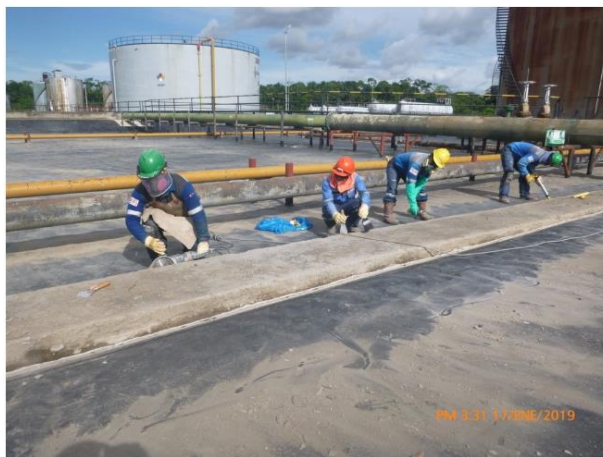
Figura 29. Limpieza y sellado de juntas con Sikaflex. Tomado de “Impermeabilización de áreas estancas Lote 8”, por D. Manrique, 2019.
