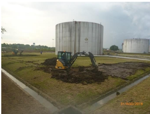
Figura 8. Retiro Top Soil con Maquinaria
