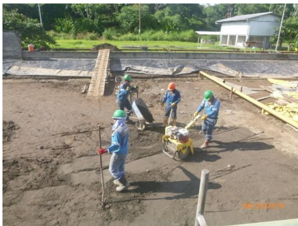
Figura 16. Reporte de obra, impermeabilización de estancas Lote 8
