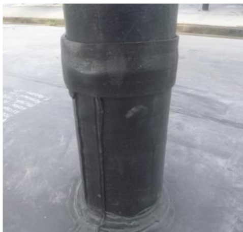
Figura 25. Aplicación de cinta de Butilo
