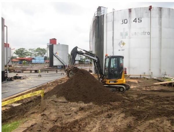
Figura 14. Terraplenado con maquinaria
