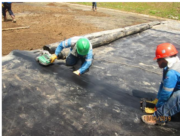
Figura 24. Soldeo de geomembrana con cuña-Tomado de “Preparación de concreto para colocar inserto de HDPE-Trabajos en horario extendido y/o nocturno- Documento PL08-1000-Q4-B-056 , por INMAC,
