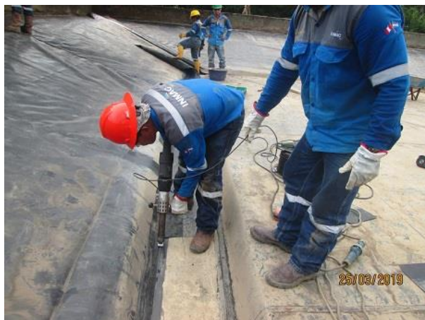
Figura 22. Soldeo de geomembrana con extrusora
