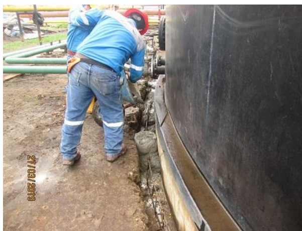
Figura 17. Vaciado de sardinel perimetral de tanques
