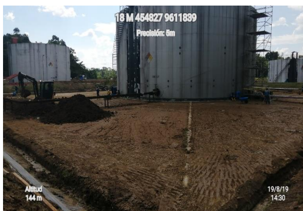
Figura 13. Excavación de terreno con maquinaria. Tomado de “Impermeabilización de áreas estancas Lote 8”, por D. Manrique, 2019.
