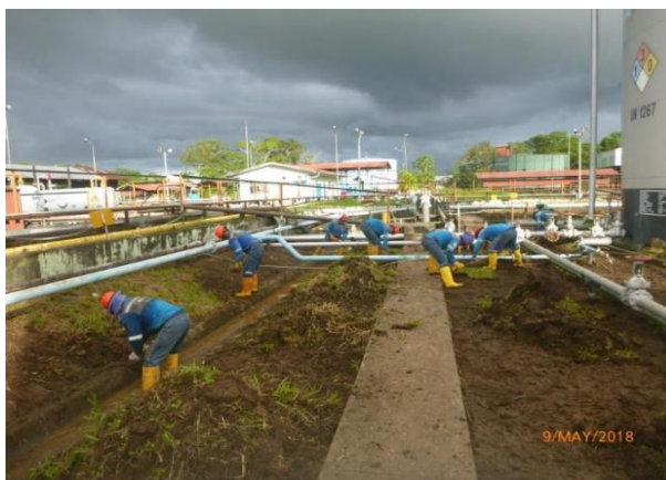
Figura 9. Retiro Top Soil con Manual
