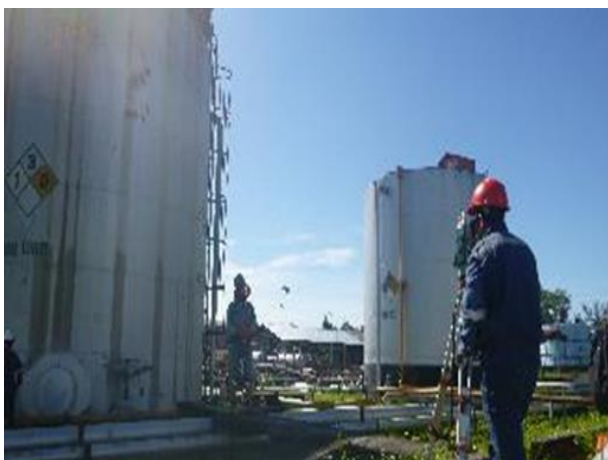
Figura 10. Control Topográfico de Áreas Estancas-Bat.1. Excavación de material propio manual
