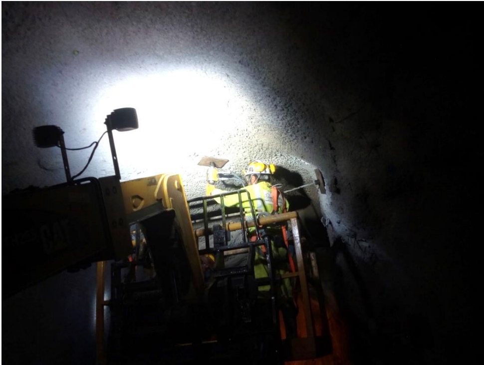
Figura 71: Control previo del macizo rocoso.
