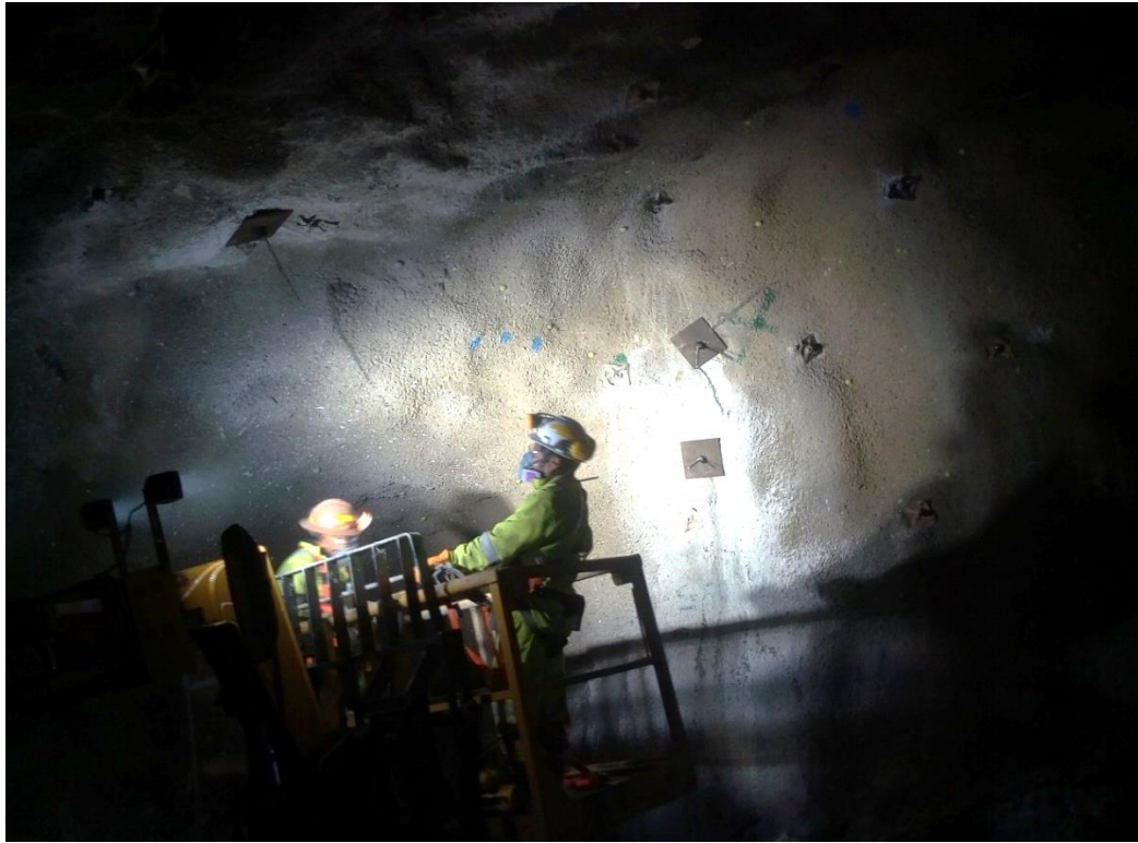
Figura 74: Verificación proceso de instalación de los cables.
