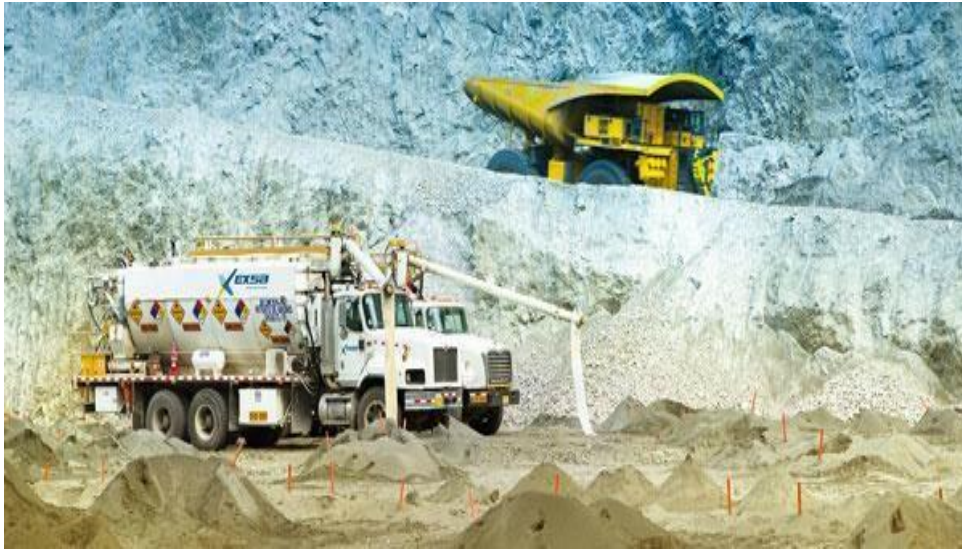
Figura 21: Carguío de los taladros en Open pit.
