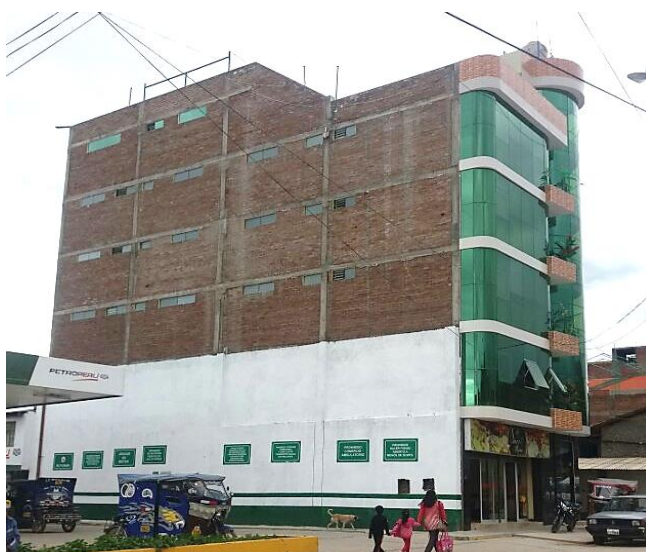
Figura 5: Vivienda de 5 pisos en Av. Bolognesi y Av. Mariscal Cáceres
