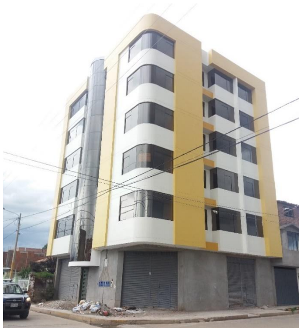
Figura 4: Vivienda de 6 pisos Av. Iquitos y Jr. Dos de mayo
