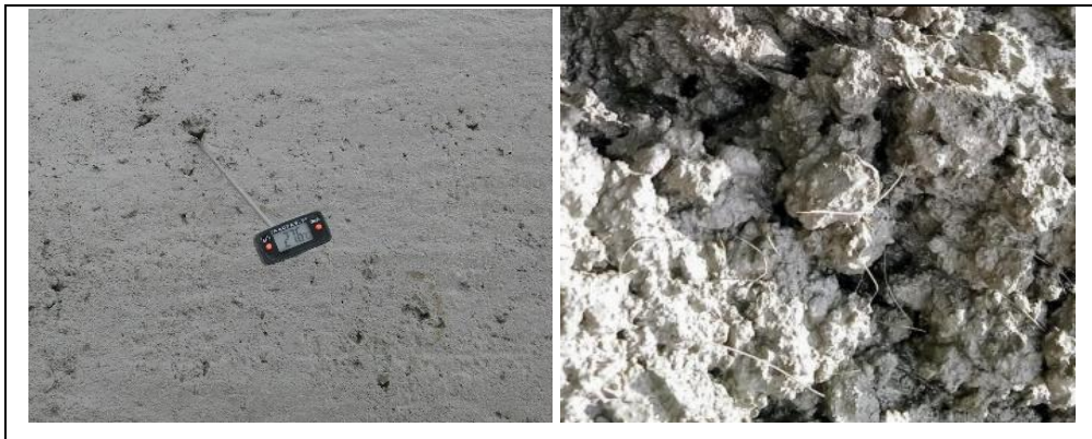
Figura 13: Temperatura del concreto premezclado sin y con fibras
