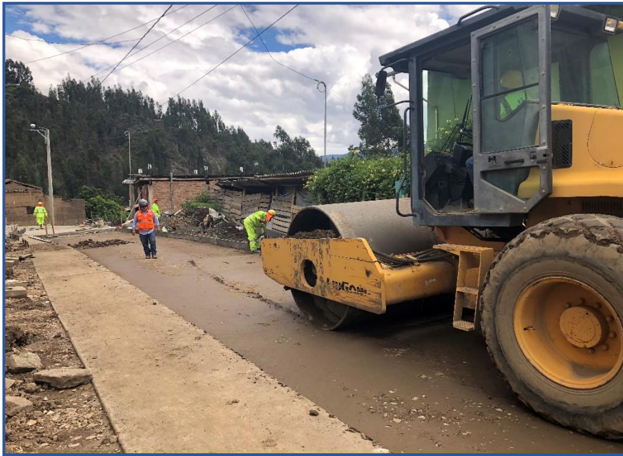
Figura 35. Equipo de trabajo movimiento de tierras.
