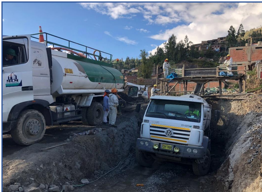
Figura 38. Planta de concreto artesanal
