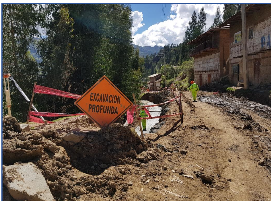
Figura 32. Falta de personal obrero y maquinaria para esta actividad.
