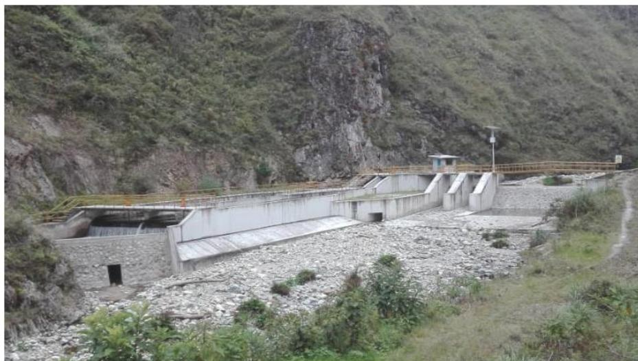
Aguas abajo se ha construido un desripador, luego un canal de aproximación que conecta con unas compuertas de regulación de flujo de 1.50 m de ancho por 1.00 m de alto, inmediatamente aguas arriba se prevé ranuras para instalación de ataguía para emplear en caso de requerirse realizar el mantenimiento o reparación de la compuerta.
