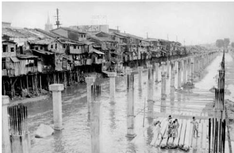
Figura 19: INICIO DE LA OBRA DE CUBRICIÓN DEL RÍO CHEONG GYE CHEON A PRINCIPIOS DEL SIGLO XX.
