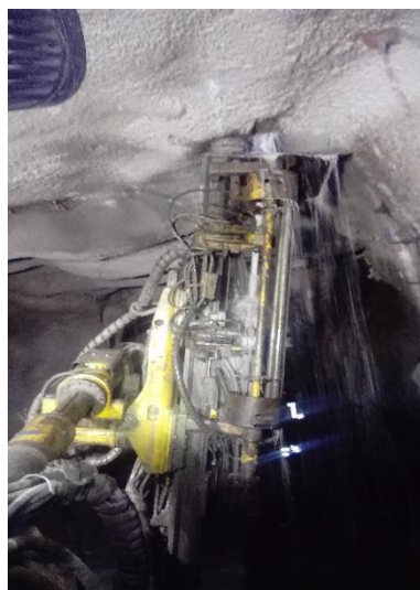
Figura 43. Perforación de taladros largos (+)
