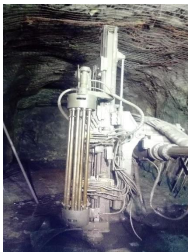
Figura 45. Realización de chimenea
