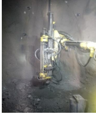
Figura 38. Perforación en paralelo (+)
