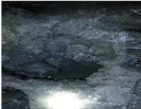
Figura 67. Taladro tapado por la cantidad de carga, debido a la falta de raspado de piso.
