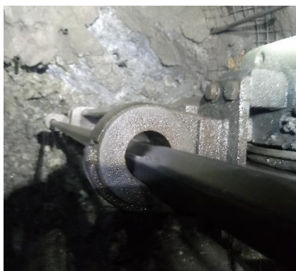
Figura 36. Desgaste del centralizador intermedio
