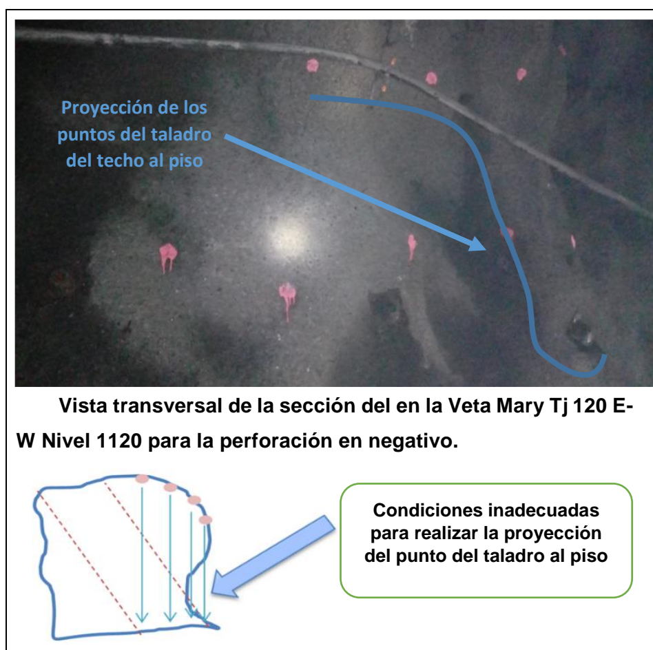
Figura N. 53. Marcado de malla hasta la mitad del hastial superior con dificultades para proyectar el punto del taladro al piso.
