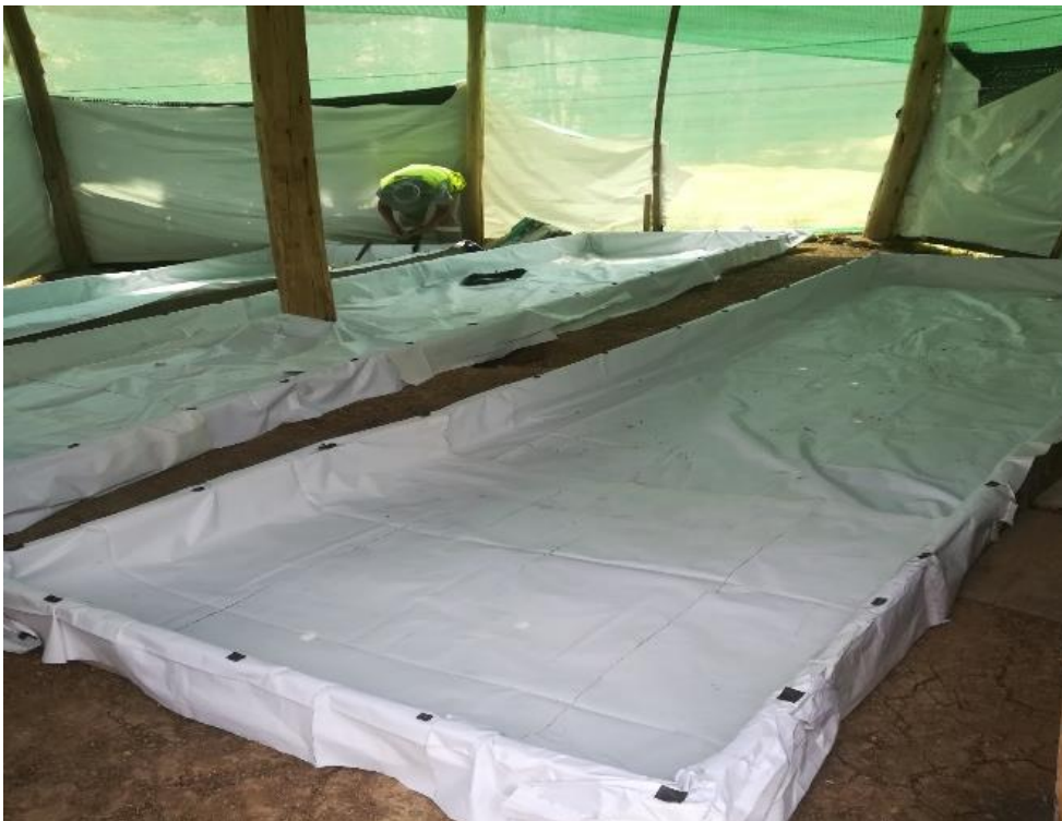
Fotografía N°02 Instalación e impermeabilización de las pilas de compostaje
