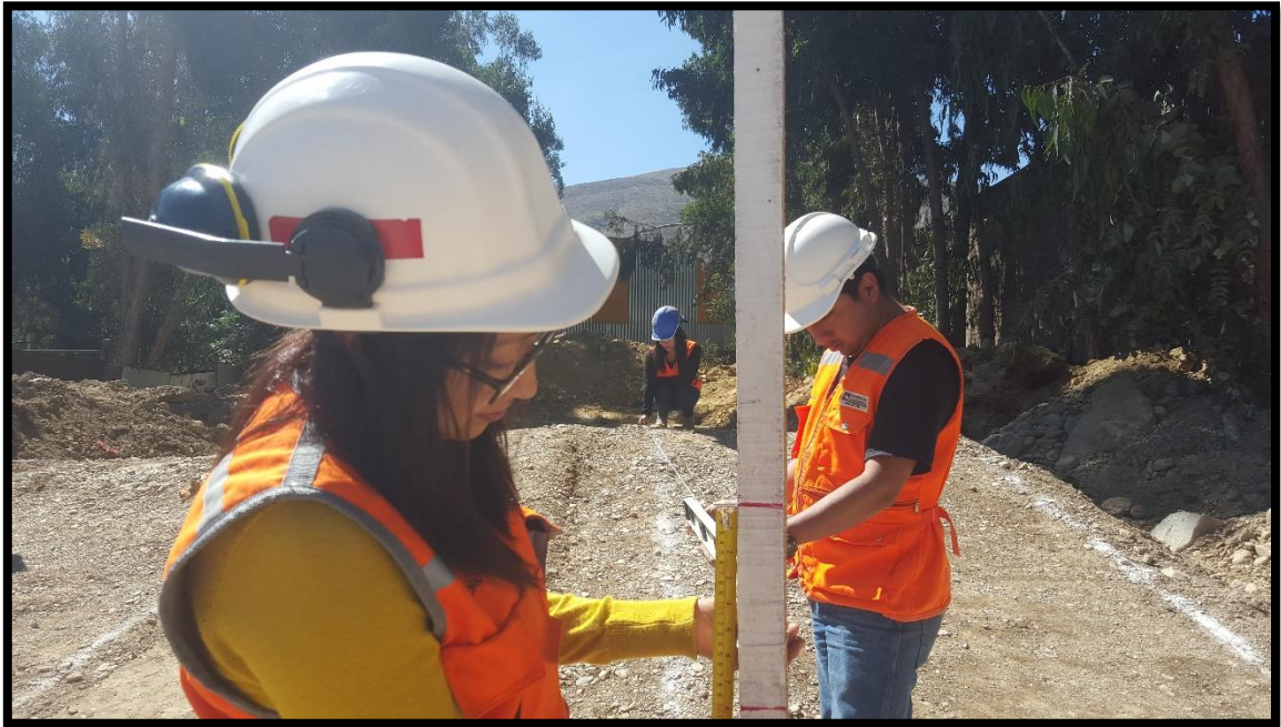
Figura 36: Determinación de diferencial de alturas después de la compactación.
