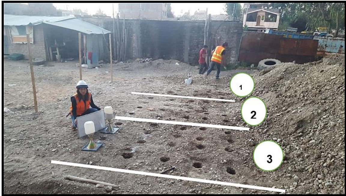
Figura 43: Culminación del Ensayo cono de Arena en las 3 franjas.
