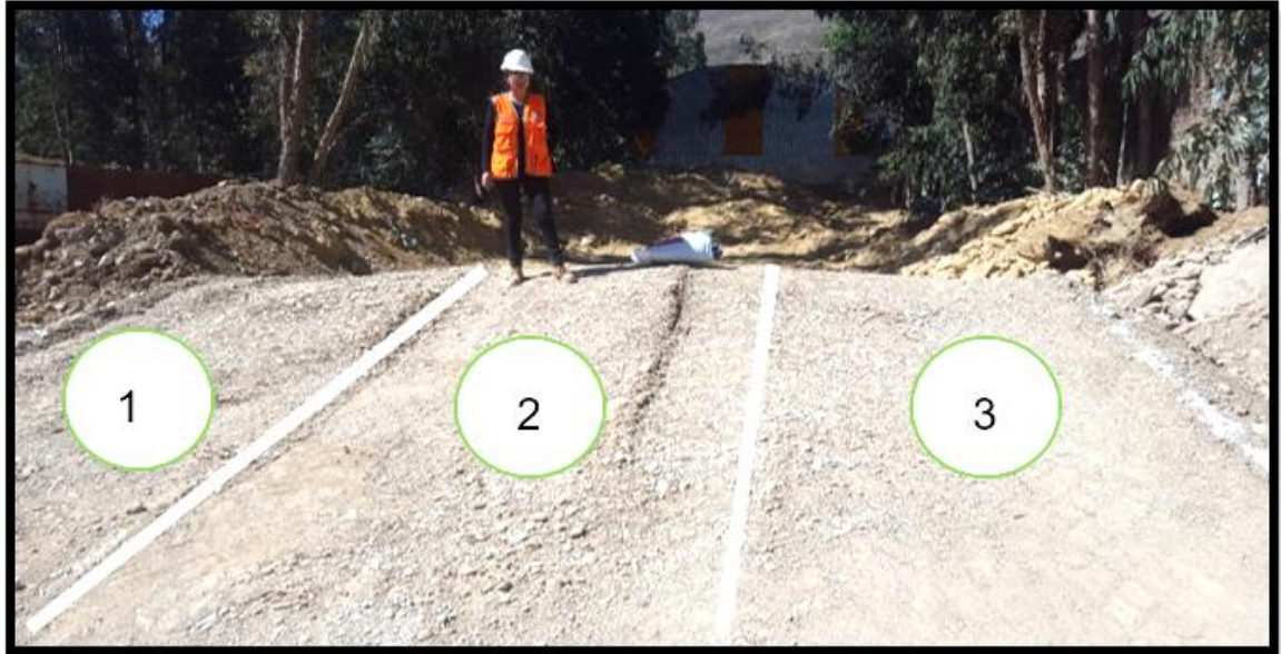
Figura 33: Tramos de prueba Compactados.
