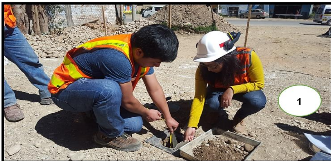
Figura 38: Extracción del Material del Agujero.
