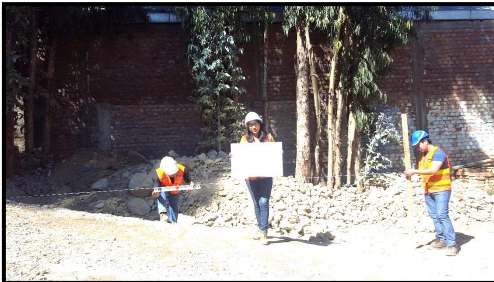
Figura 35: Nivelación y marcación de alturas.
