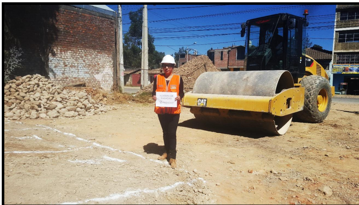
Figura 30: Compactación 2 pasadas con rodillo de 12 ton.
