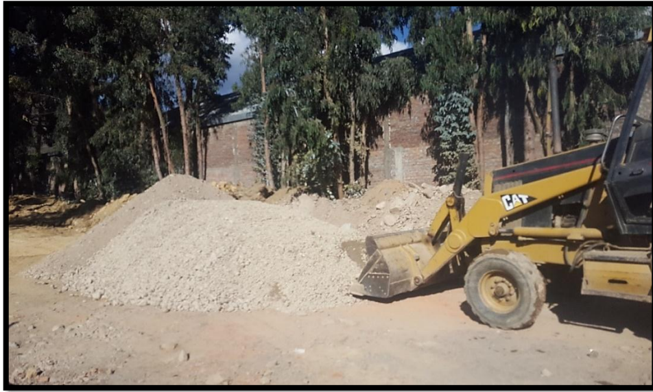
Figura 27: Acopio del Material
