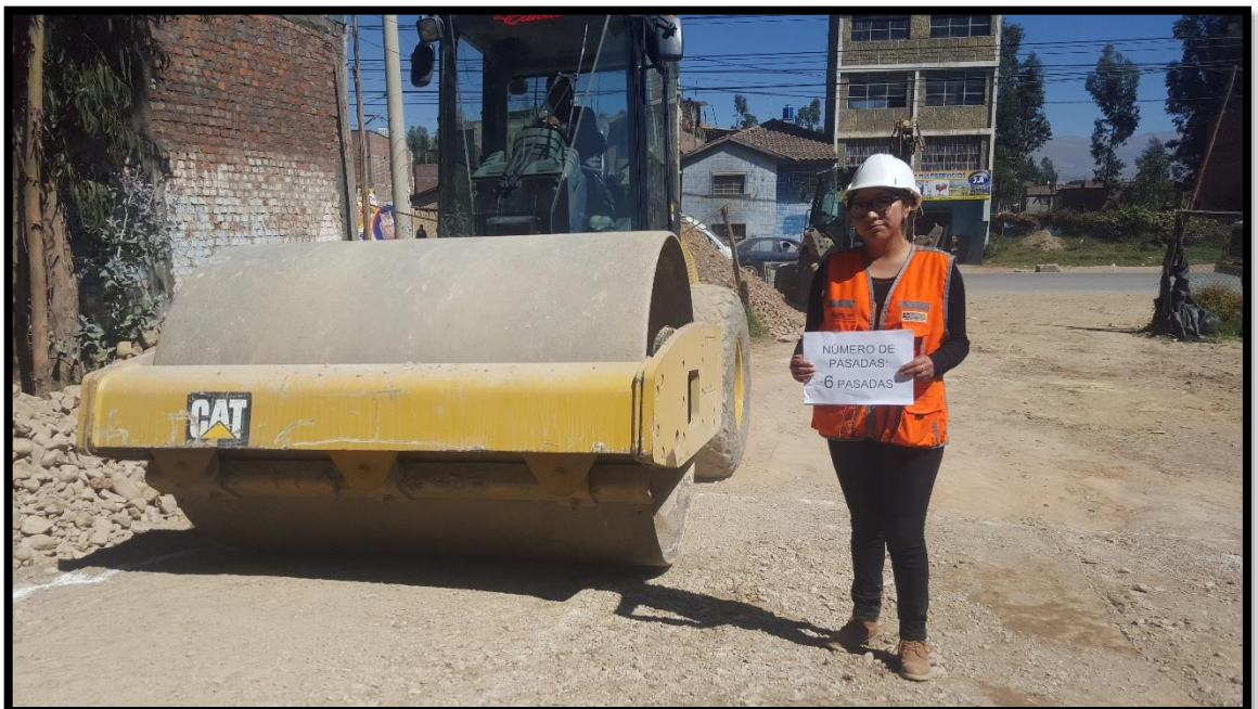
Figura 32: Compactación 6 pasadas con rodillo de 12 ton
