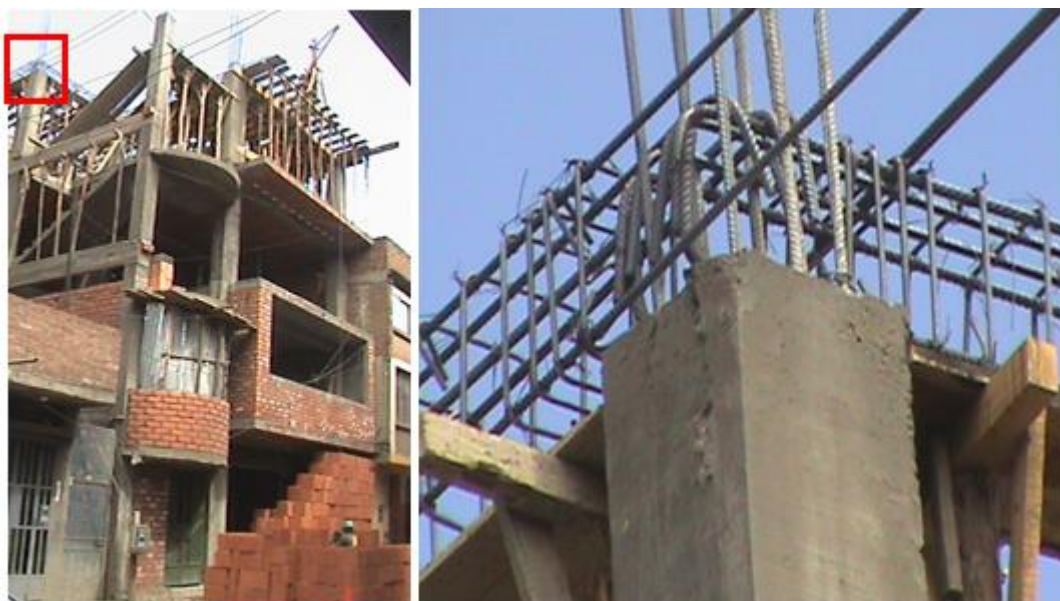
Figura 4: Acero longitudinal de la viga no confinada en el núcleo de la columna
