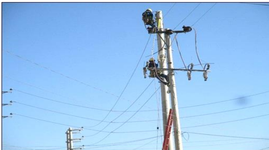
Figura 14: Retiro de seccionamiento de la estructura AP06090 poste de 13/400 e instalación de retenida en poste de 15/400.
