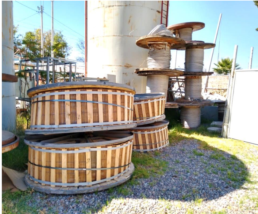
Figura 12: Almacenamiento de Conductor de AAAC de 70 mm 2
