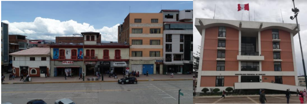
Figura 59. Materiales de las edificaciones del entorno
