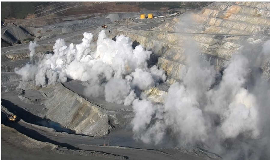
Figura 55. Postvoladura sin emisión de gases.
