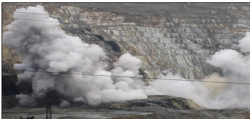
Figura 19. Ausencia de gases nitrosos.
