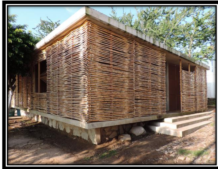
Figura 7: Edificio comunitario de muros de bahareque y celosía de carrizo
