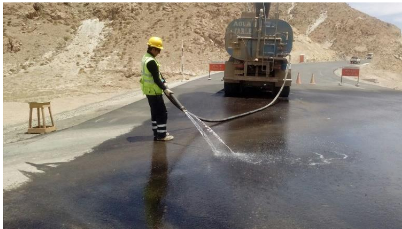
Figura N°44: Limpieza de vía para colocación de marcas permanentes en el pavimento
