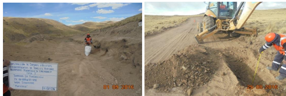
Figura N°68: Evaluación de terreno
