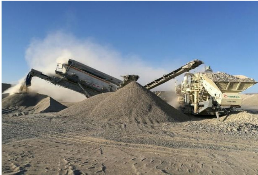
Figuras N° 34. Trabajos de procesamiento de material para mezcla asfáltica
