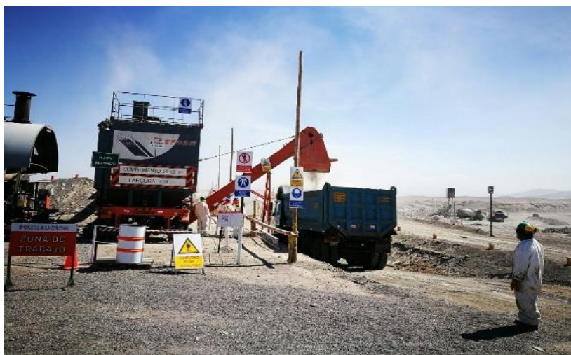
Figura N°39: Preparación de mezcla asfáltica
