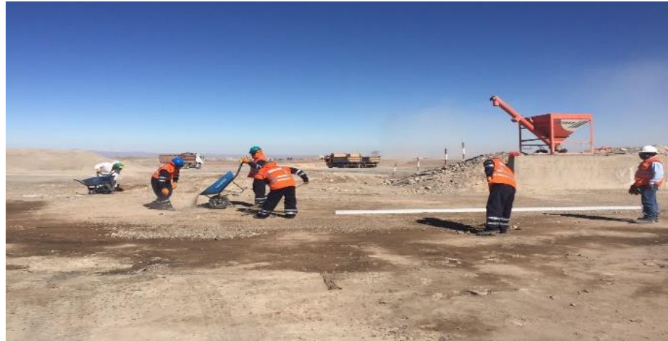
Figura N°24: Nivelación del área designada del laboratorio
