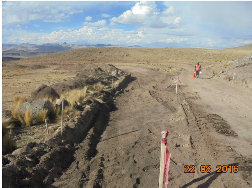
Figura N°66: Limpieza y desbroce del km 03+300 al 02+960
