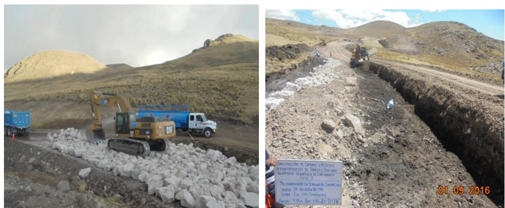
Figura N°69: Mejoramiento a Nivel de Subrasante
