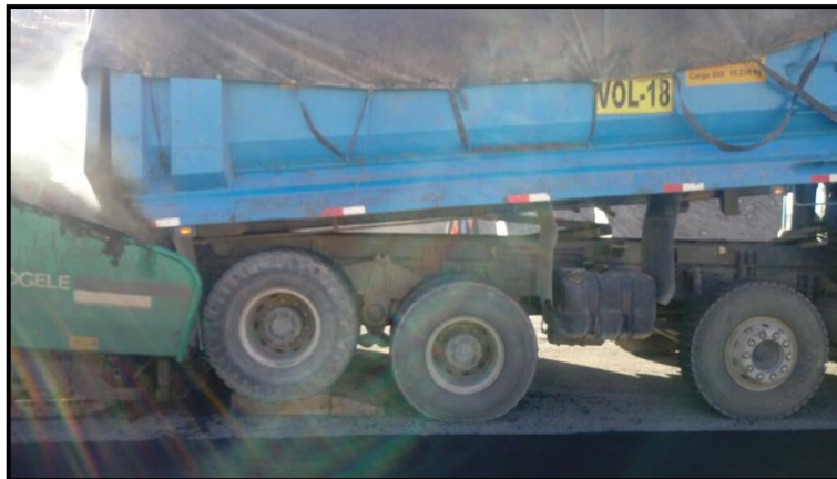
Figura N°82. Implementación de tacos en la tolva de la pavimentadora
