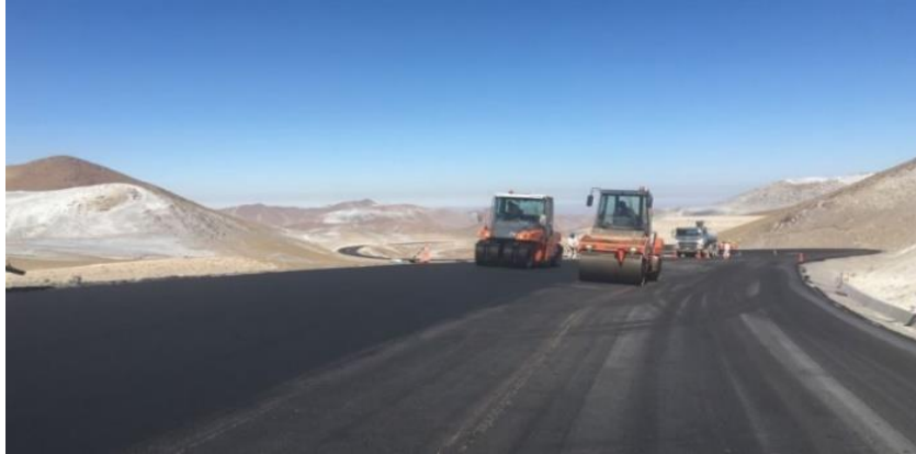
Figura N°43: Compactación de la mezcla asfáltica
