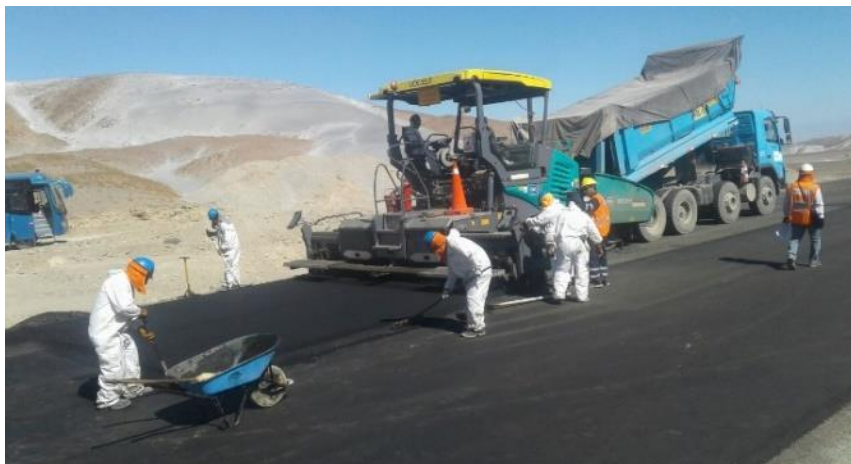
Figura N°42: Colocación y extendido de mezcla asfáltica
