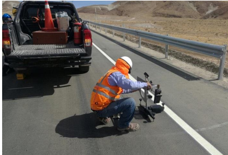
Figura N°52: Controles post asfaltado de resistencia al deslizamiento con péndulo inglés TRRL
