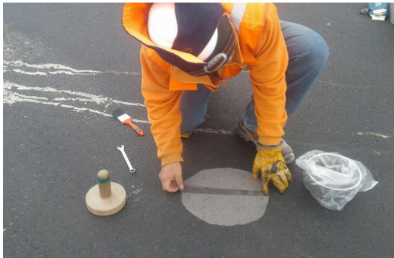
Figura N°53: Controles post asfaltado textura superficial con el método circulo de arena
