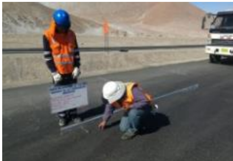
Figura N°54: Controles post asfaltado de regularidad superficial – Control de Lisura
