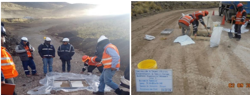
Figura N°72: Liberación de terreno de Fundación
