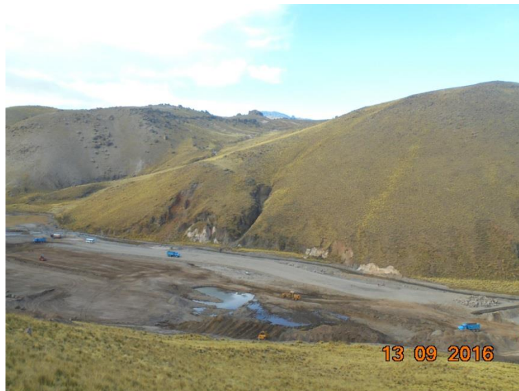
Figura N°67: Limpieza y desbroce en plataforma Chalhuanca
