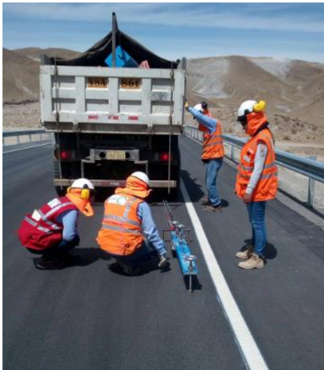
Figura N°56: Controles post asfaltado con equipo Viga Benkelman
