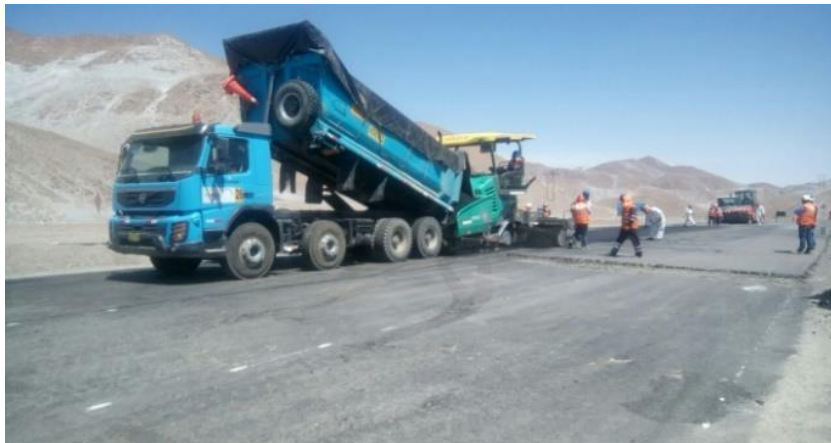
Figura N°41: Descarga de volquete con mezcla asfáltica a la pavimentadora
