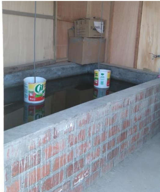
Figura N°64: Poza de Curado de concreto
