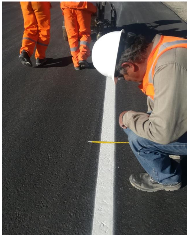
Figura N°47: Control de espesores de marcas permanentes en el pavimento
