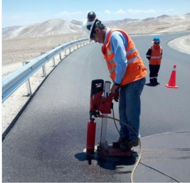
Figura N°55: Controles post asfaltado con equipo de diamantina para verificar vacíos, densidad y espesor de núcleos
