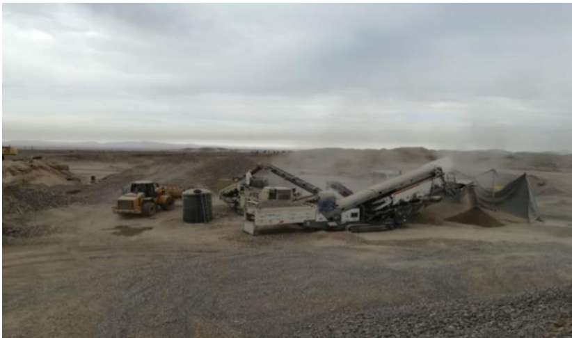
Figuras Nº 32. Procesamiento de los agregados para el asfalto
