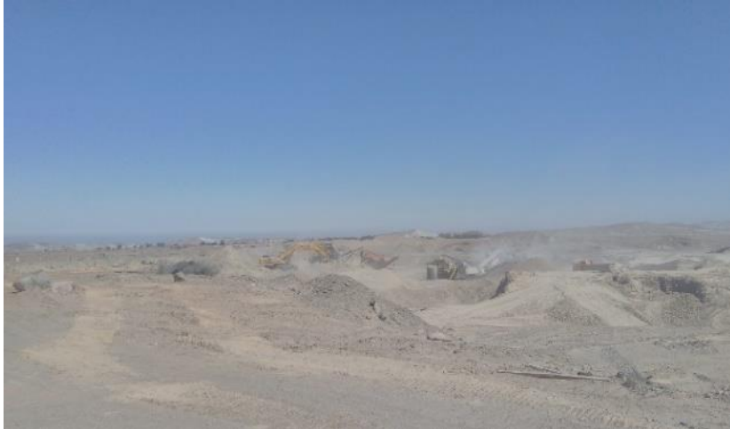
Figuras Nº 31. Extracción y zarandeo de material integral por parte del proveedor de agregados para asfalto
