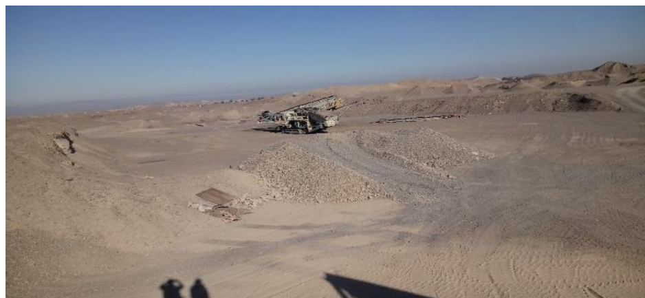
Figura N°23: Conformación del área para laboratorio de instalación de planta de asfalto en Cantera Elena de Troya
