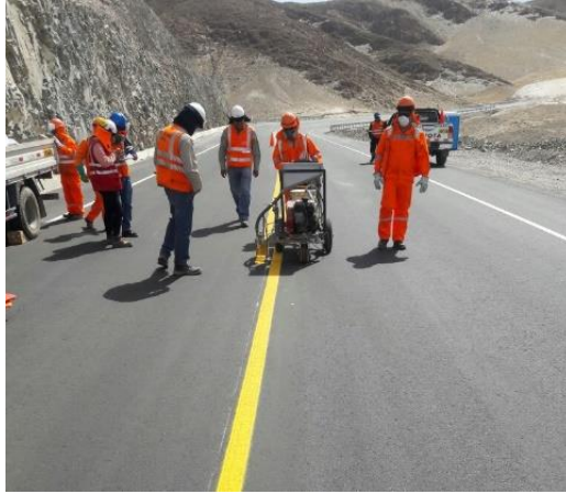
Figura N°48: Marcas permanentes en el pavimento color amarillo
