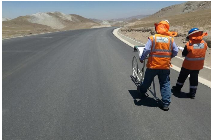
Figura N°51: Controles post asfaltado con equipo MERLI - Rugosidad Superficial
