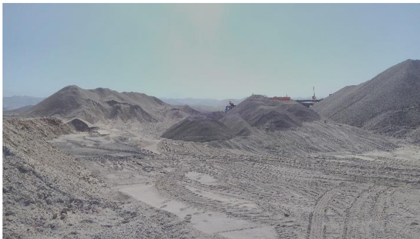
Figuras Nº 33. Acopios temporales de agregados para preparación de mezcla asfáltica
