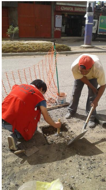
Fotografía N° 17 Aplicación del ligante en bordes
