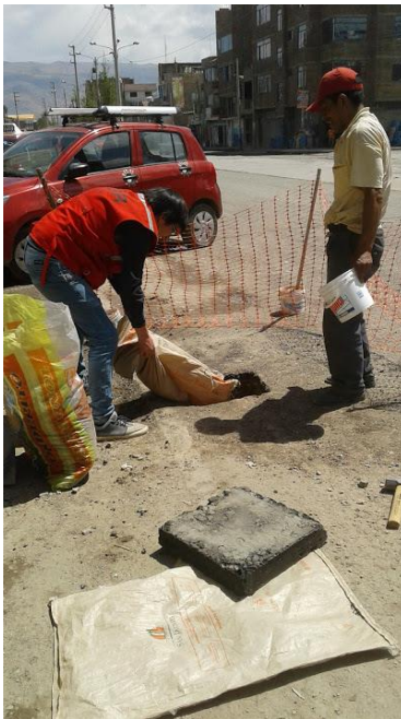
Fotografía N° 16 Colocado del parche
