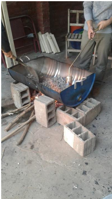
Fotografía N° 4 Vertido de mezcla en el molde
