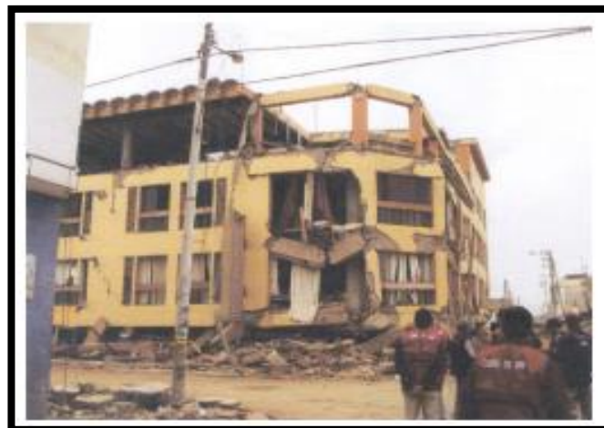
Figura 4: Hotel Embassy colapsado ante el sismo de Pisco, Perú 2007
