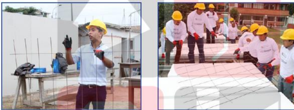
Figura 116: Colocación de la malla de temperatura en las viguetas prefabricadas Firth.
