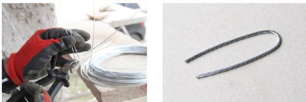
Figura 108: Colocación alambre galvanizado @ 20cm en el Sistema de Vigacero parte II.
