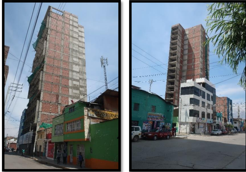
Figura 7: Edificio con irregularidad de torsión en la ciudad de Huancayo 2018.
