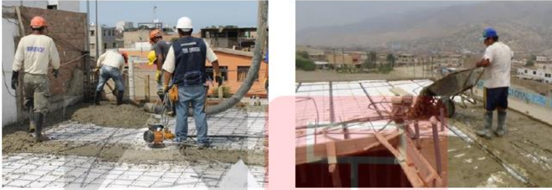
Figura 103: Vaciado del concreto premezclado o insitu.
