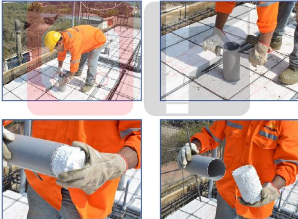
Figura 95: Detalle de la colocación de las instalaciones eléctricas parte I.
