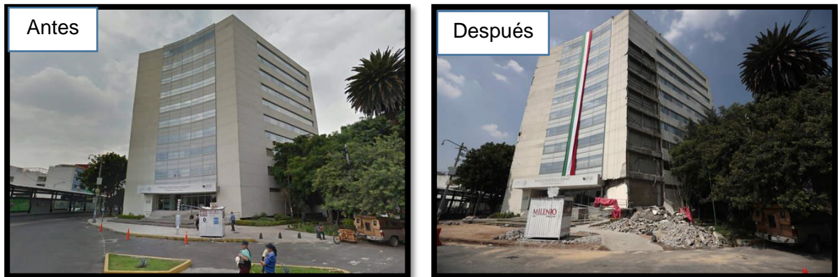
Figura 1: Edificio Federal, antes y después del terremoto de México 2017.
