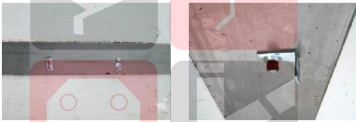
Figura 107: Colocación alambre galvanizado @ 20cm en el Sistema de Vigacero parte I.
