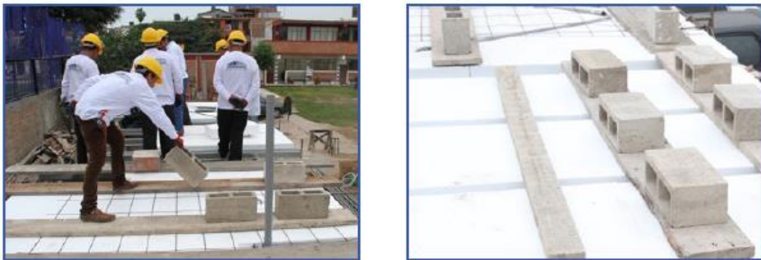
Figura 94: Detalle del montaje de los casetones de EPS.
