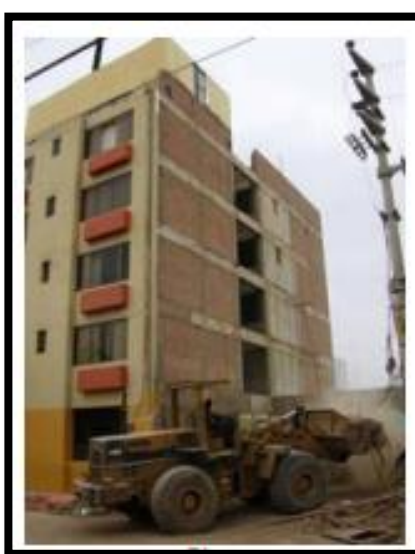
Figura 5: Edificio con muro de concreto armado
