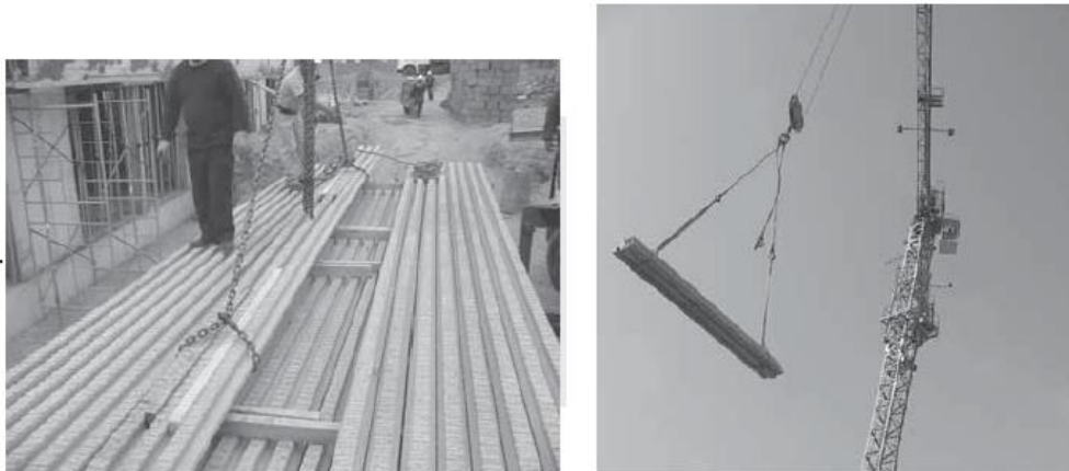
Figura 119: Izaje de las viguetas prefabricadas Firth en obra parte II.
