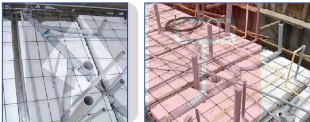
Figura 97: Detalle de la colocación de las instalaciones sanitarias parte I.
