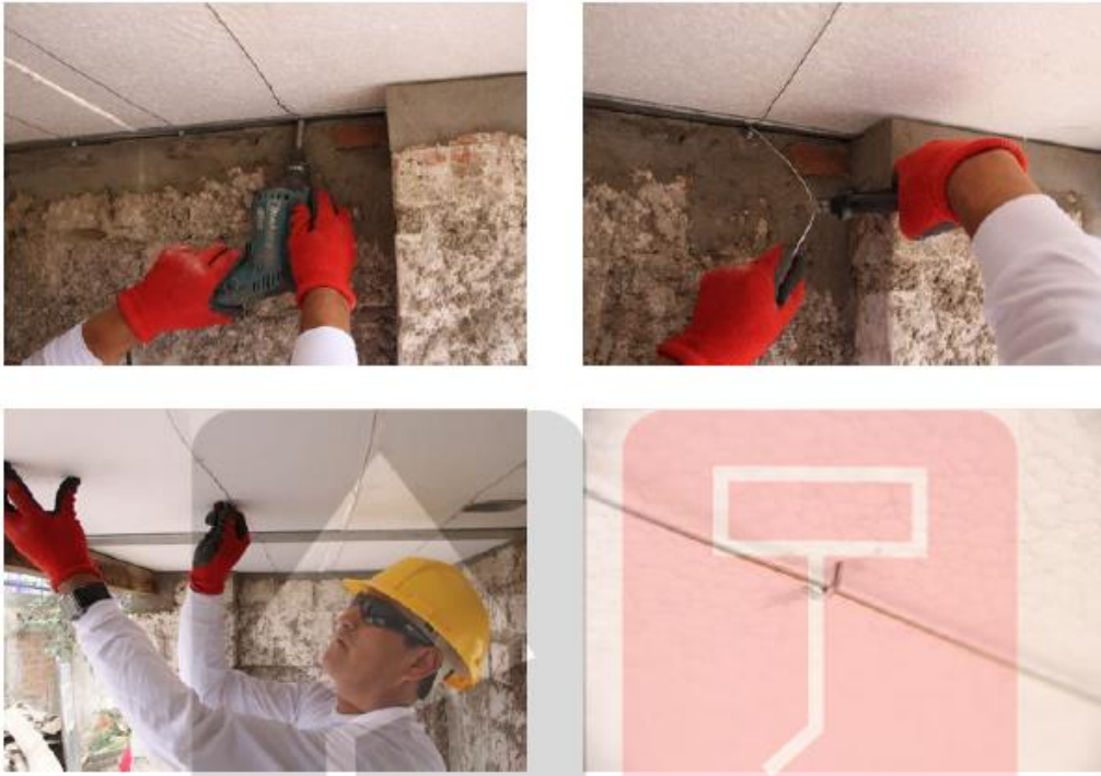
Figura 109: Colocación alambre galvanizado @ 20cm en el Sistema de Vigacero parte III.
