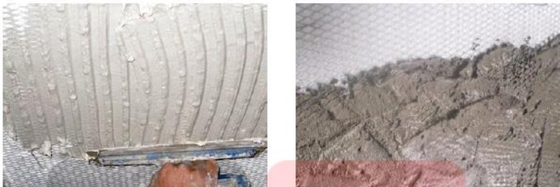
Figura 106: Colocación de la pasta de cemento con un puente adherente en el Sistema de Vigacero.
