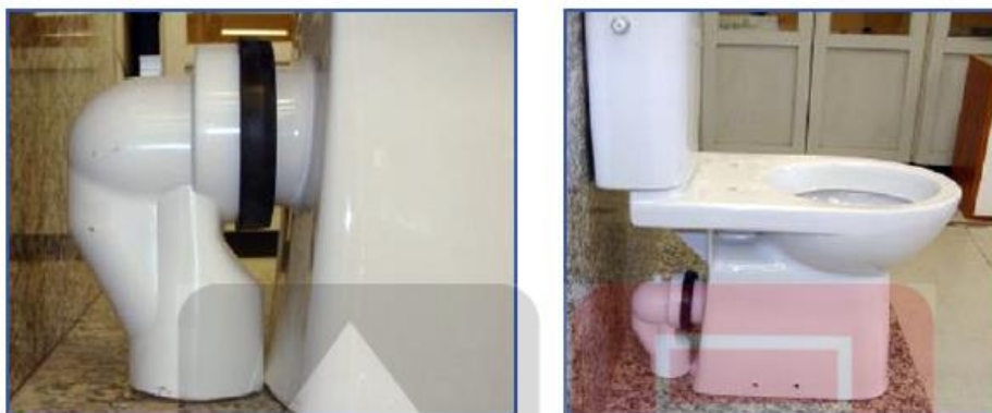
Figura 99: Detalle de la colocación de las instalaciones sanitarias parte III.
